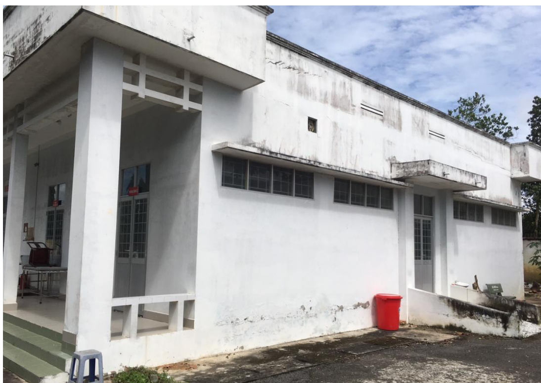
Tường bị bong tróc, ẩm mốc – sàn sân ô mái bị thấm
