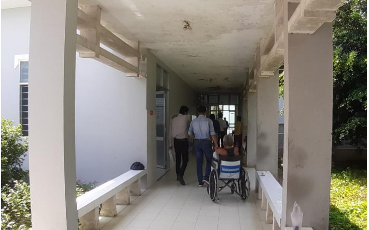
Sàn mái bị thấm
