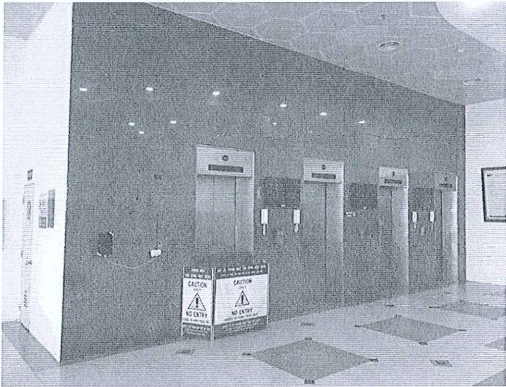
Mặt trước buồng thang máy hiện trạng-Tầng 1
