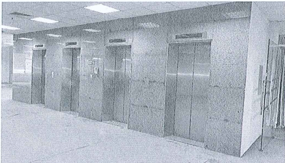
Mặt trước buồng thang máy hiện trạng -Tầng 2
