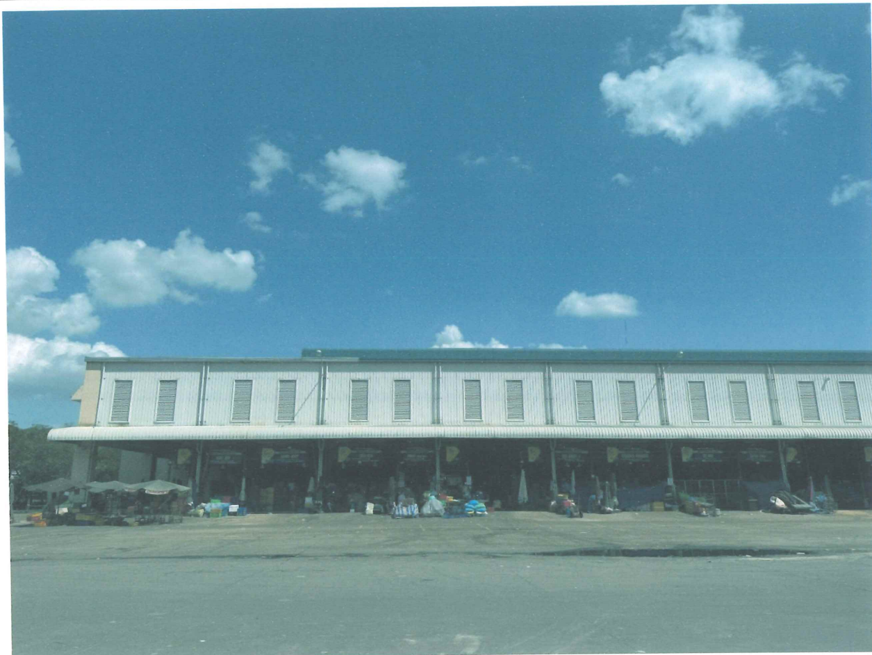
Hình 2-10: Khu vực sân bãi tại Nhà lồng B thuộc công trình Kho lạnh Satra
