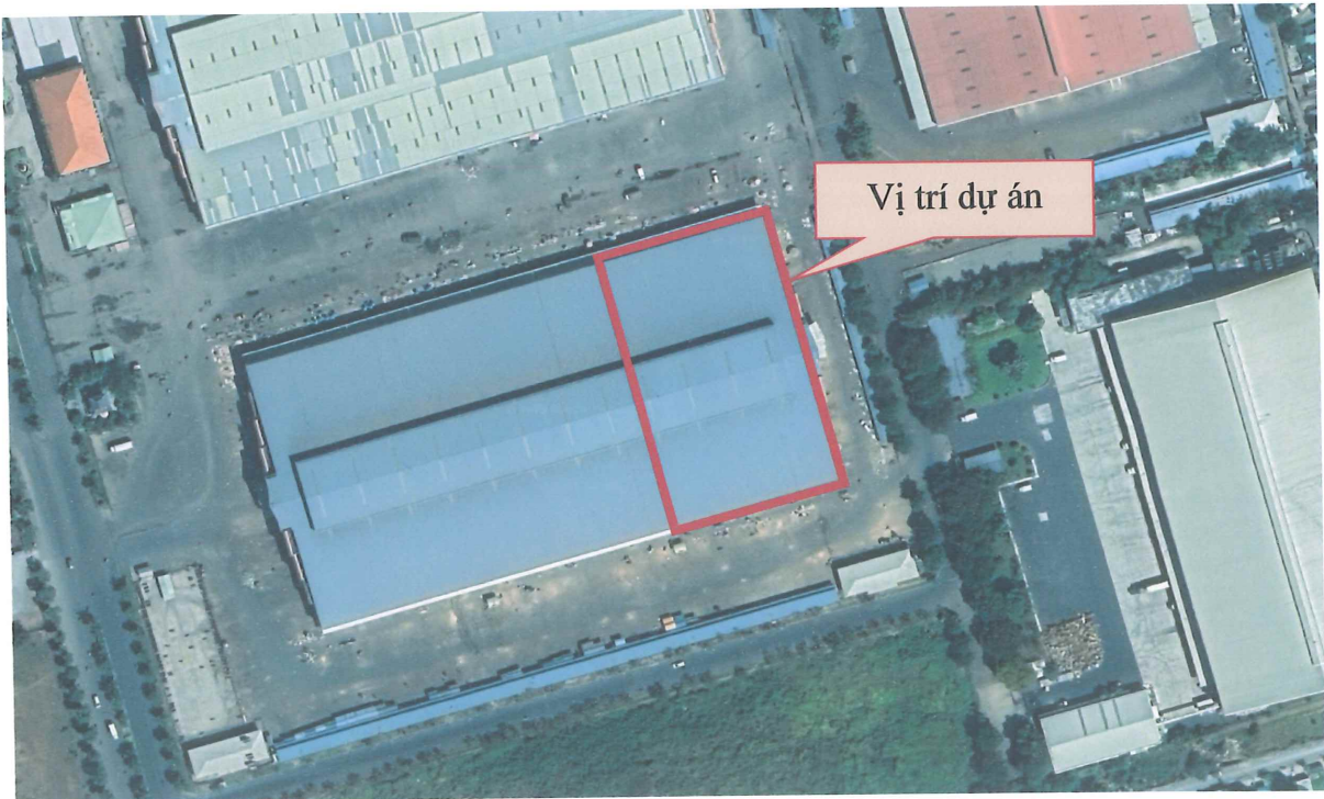
Hình 2-7: Vị trí dự án lắp đặt hệ thống điện mặt trời mái nhà tại nhà lồng B thuộc công trình Kho lạnh Satra trên Google Earth
