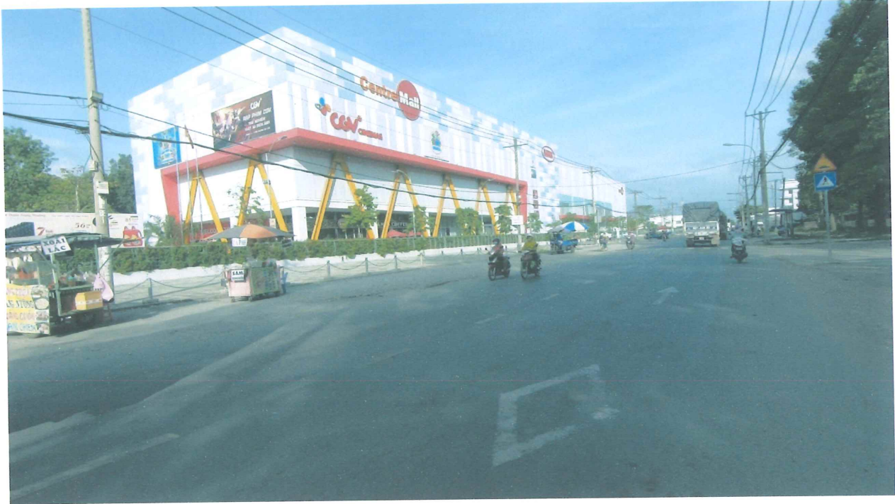
Hình 2-6: Hướng tiếp cận TTTM Satra Củ Chi từ đường tỉnh lộ 8
