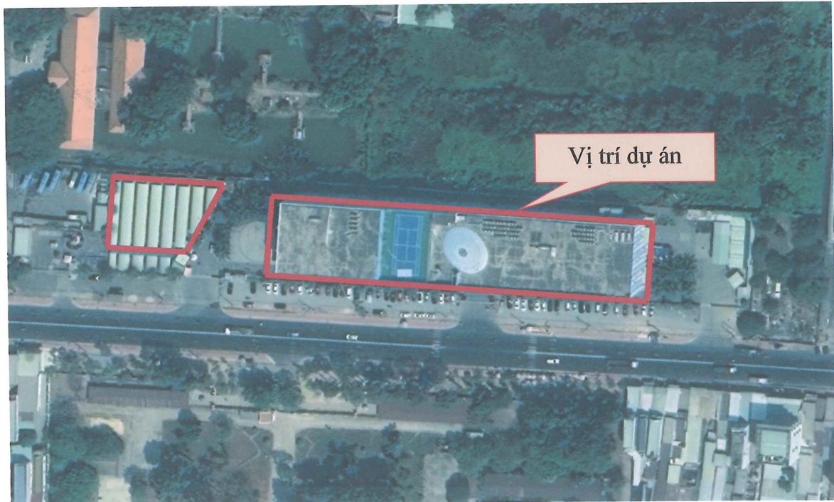
Hình 2-1: Vị trí dự án lắp đặt hệ thống điện mặt trời mái nhà tại TTTM Satra Củ Chi trên Google Earth
