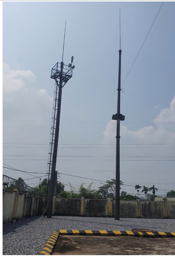
Hình ảnh hệ thống cột/kim thu sét hiện trạng trạm E1.7
