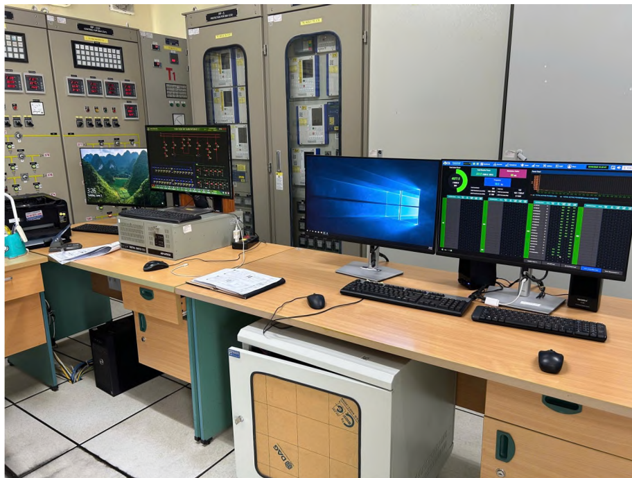
Hình 4. Hệ thống máy tính HMI
