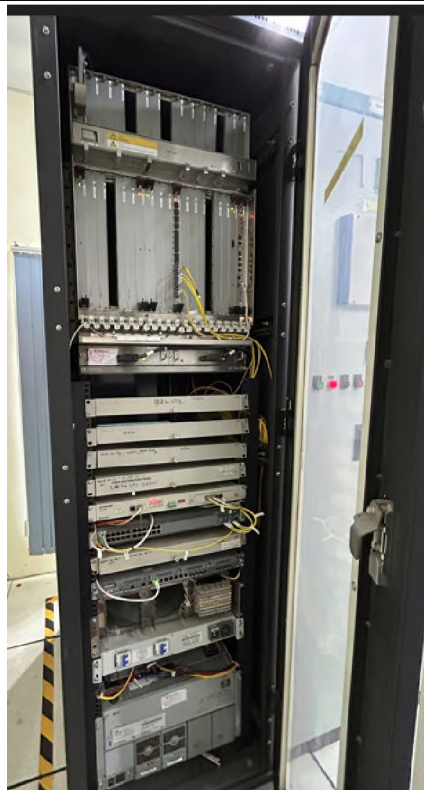
Hình ảnh hệ thống thông tin liên lạc và nguồn 48VDC
