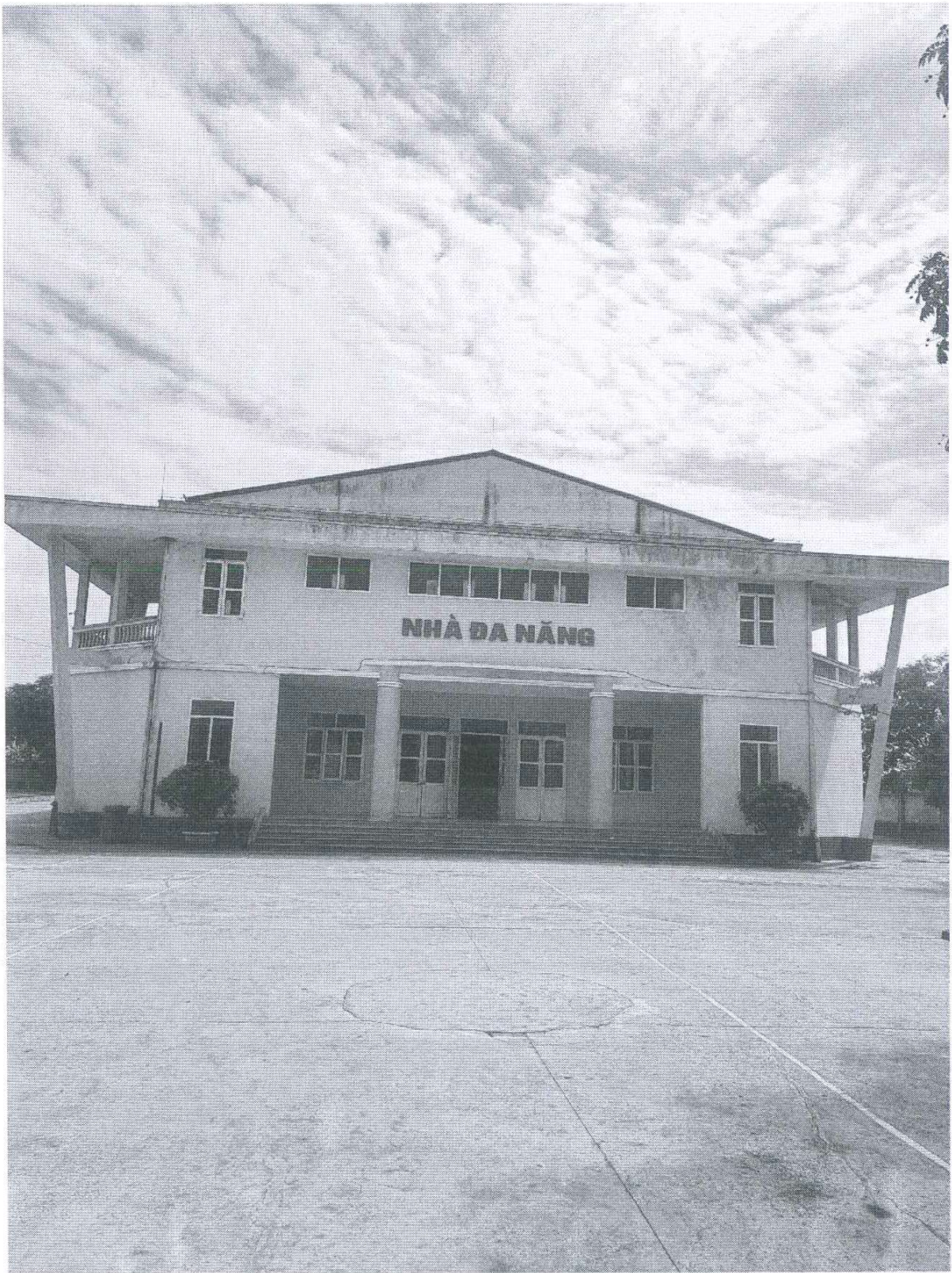
Hiện trạng nhà đa năng
