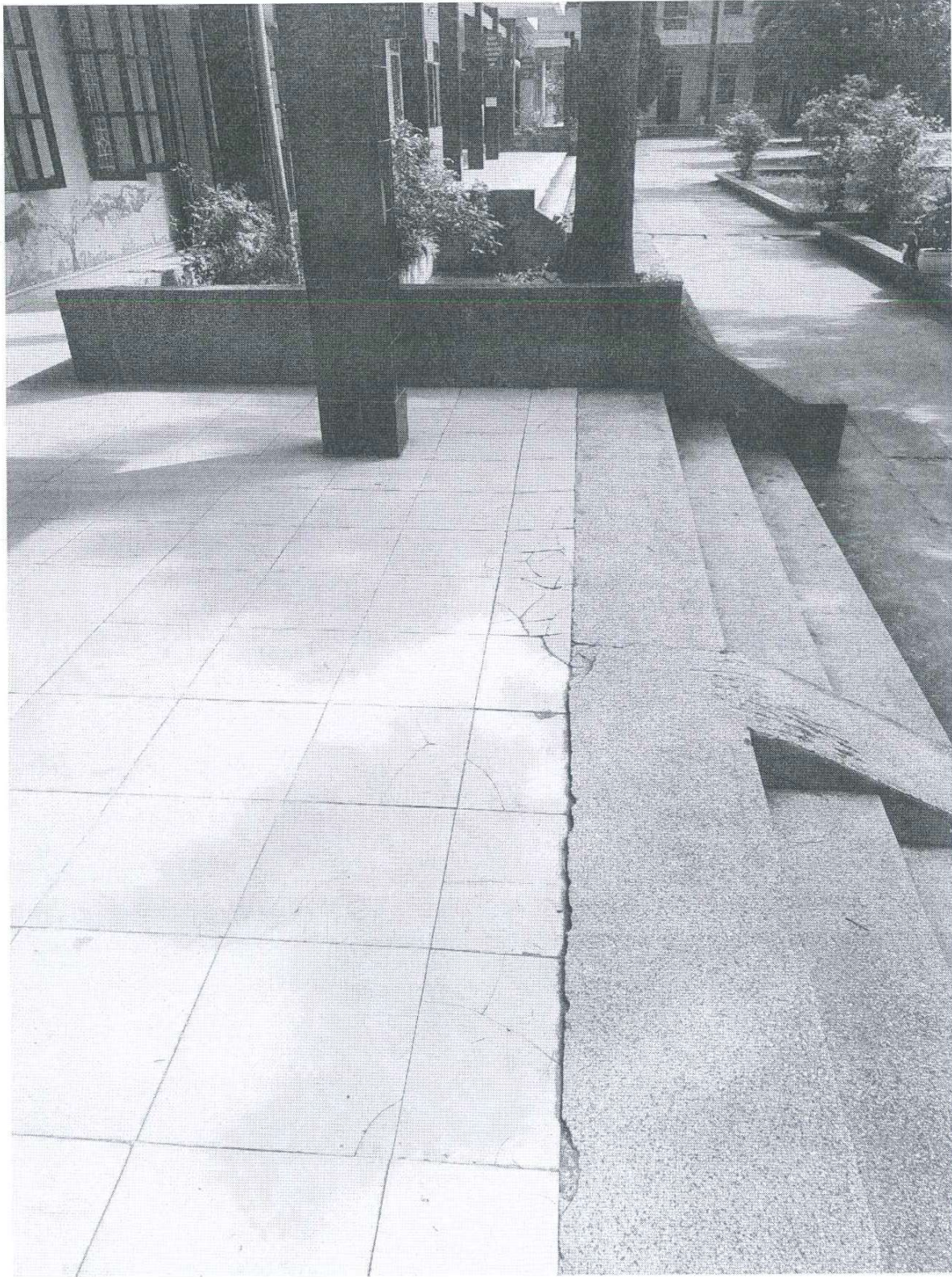
Nhiều vị trí nền bị lún, gạch lát nứt vỡ
