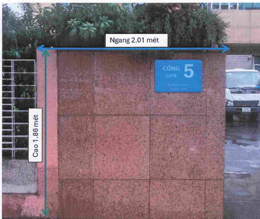
Hình 11. Hiện trạng vị trí lắp đặt Cổng 5
