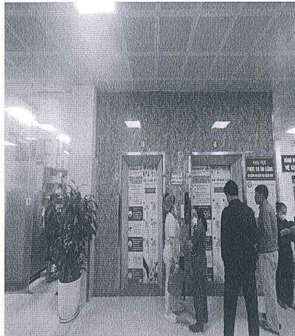
Hình 8: sảnh thang máy ốp tấm nhựa không đồng bộ, nhiều chỗ sứt, vỡ
