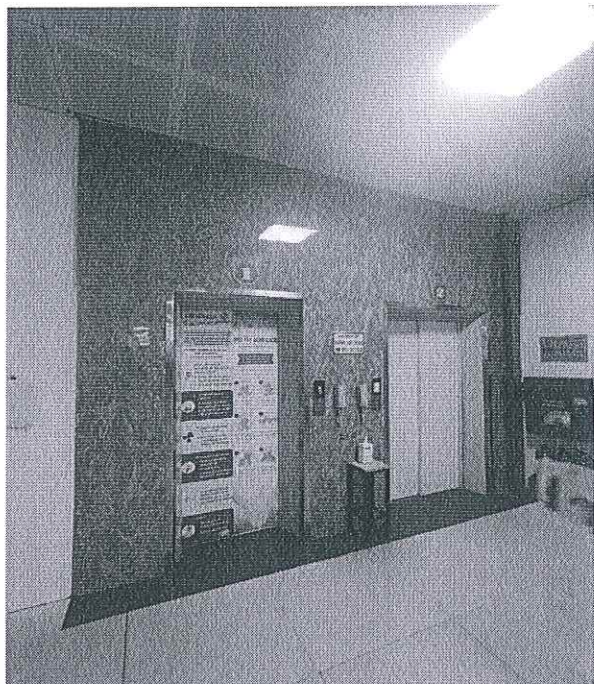
Hình 7: sảnh thang máy ốp tấm nhựa không đồng bộ, nhiều chỗ sứt, vỡ
