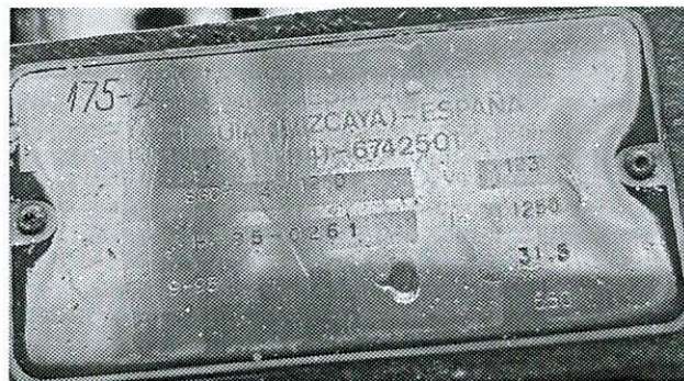
Hình 3: Hình ảnh DCL 175-2 pha B TBA 500kV Đà Nẵng
