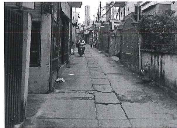
Hình 2.2.6 – Rãnh thu nước giữa đường, hẻm BT trên đường Nguyễn Ái Quốc.
