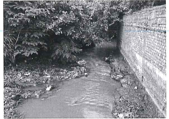
Hình 2.2.4 – Đoạn suối cuối hẻm 200, đường Nguyễn Ái Quốc, 1 bên tường rào xây sát bờ suối.
