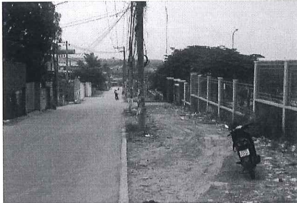
Hình 2.2.11 – Rãnh thoát nước bên trái phía trước công trình xử lý nước thải số 1, hướng dốc địa hình về suối Sắn Máu.
