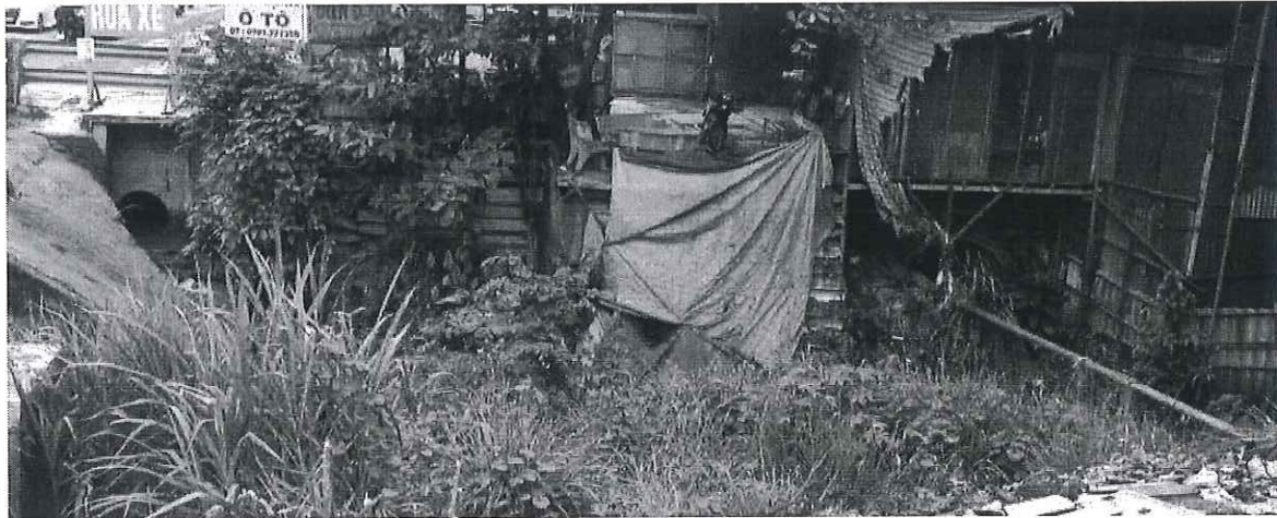
Hình 2.2.7 – Cống xả bên cầu qua suối đường Hoàng Văn Bồng, cống D1000mm và D1800mm, hướng đi về nhà máy nước Thiện Tân.
