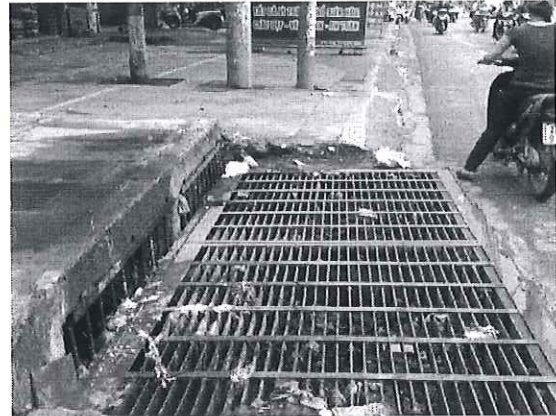
Hình 2.2.12 – Miệng và hố ga thu nước trên đường Nguyễn Ái Quốc, gần công viên 30/4.
