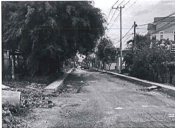
Hình 2.2.13 – Rãnh thoát nước hai bên đường của một tuyến đường đang nâng cấp.
