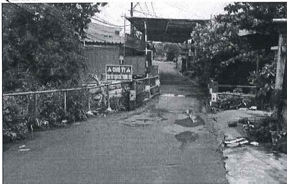
Hình 2.2.9 – Cầu qua suối hẻm 306, đường Nguyễn Ái Quốc, cửa xả hai bên cầu.
