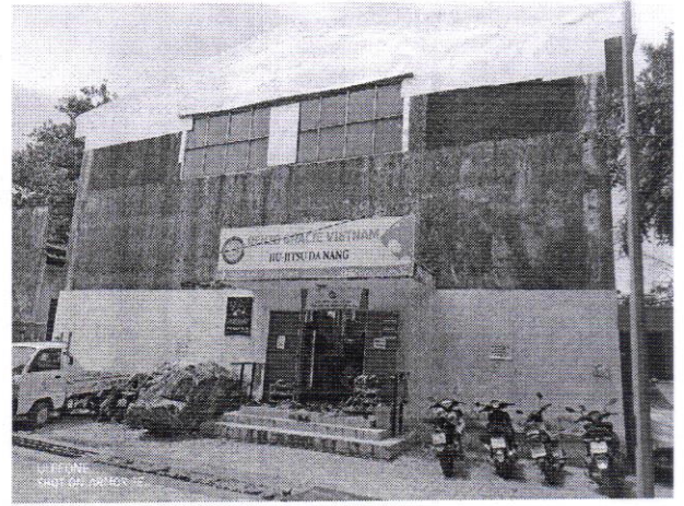
(Hiện trạng khối nhà 1 tầng)
