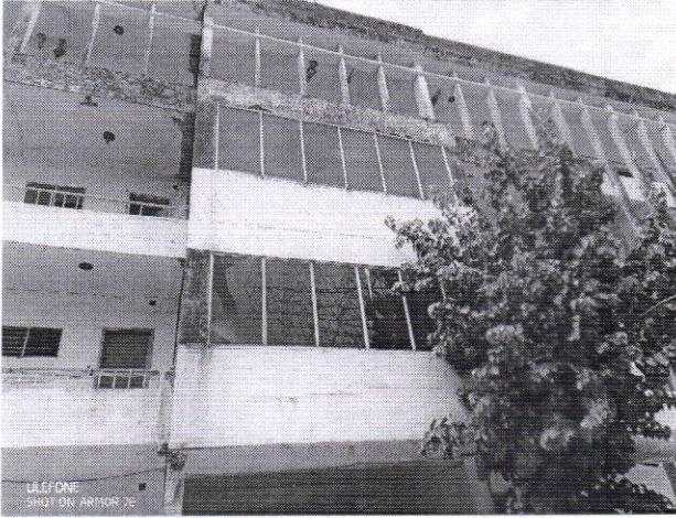
(Hiện trạng khối nhà 4 tầng)
