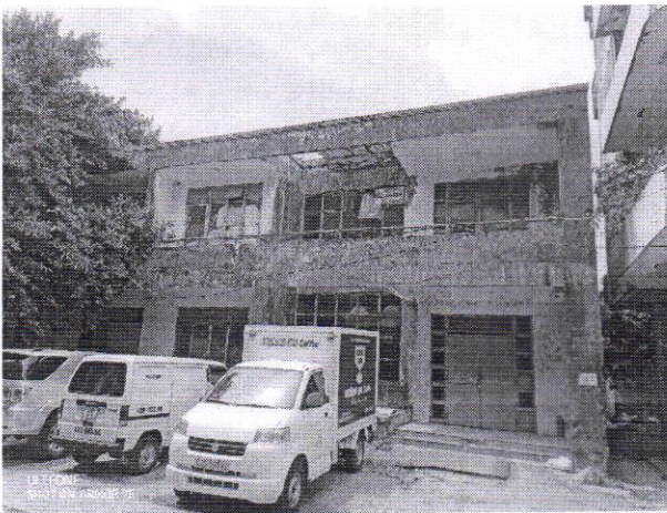
(Hiện trạng khối nhà 2 tầng)
