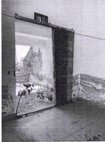
(Cửa sắt kéo tại công trình)
