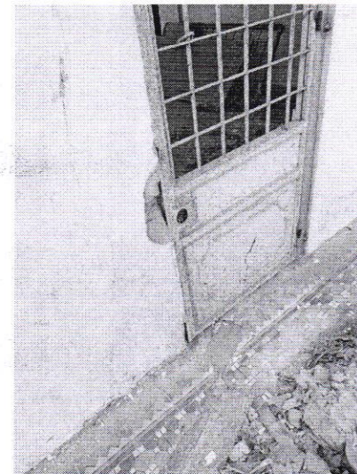
(Cửa sắt tại công trình)
