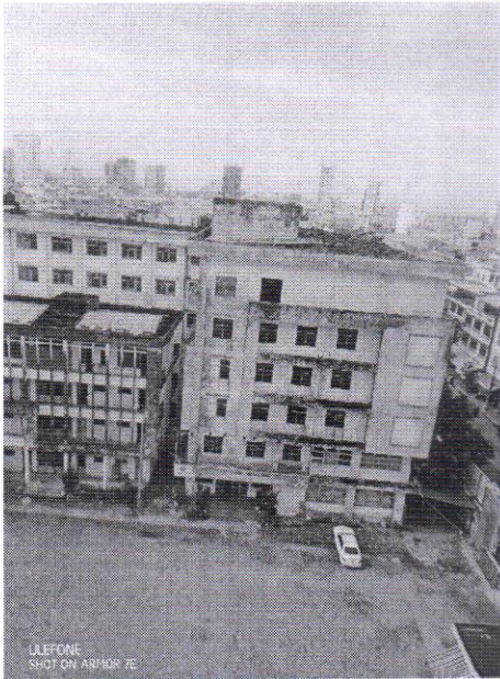
(Hiện trạng khối nhà 4 tầng-6 tầng)
