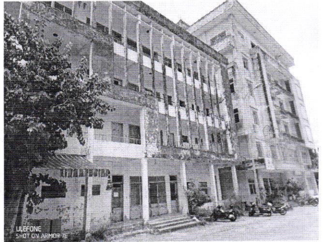
(Hiện trạng khối nhà 4 tầng-6 tầng)
