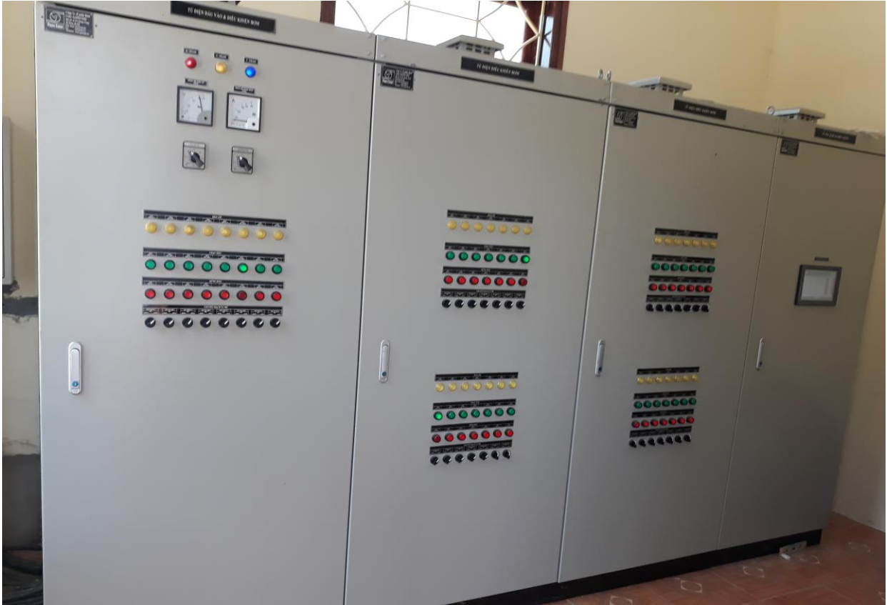
Hình 1: Tủ điều khiển trạm xử lý nước thải Nông Trường
