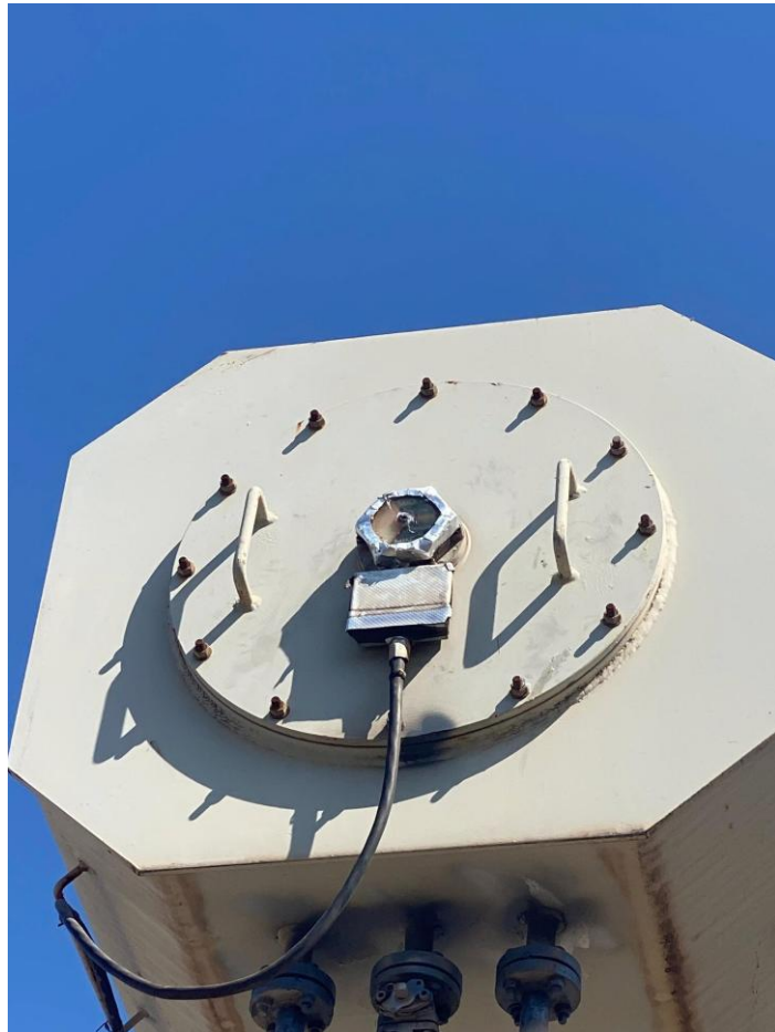
Đồng hồ chỉ thị mức dầu bộ OLTC MBA T1/Cảng Dung Quất
