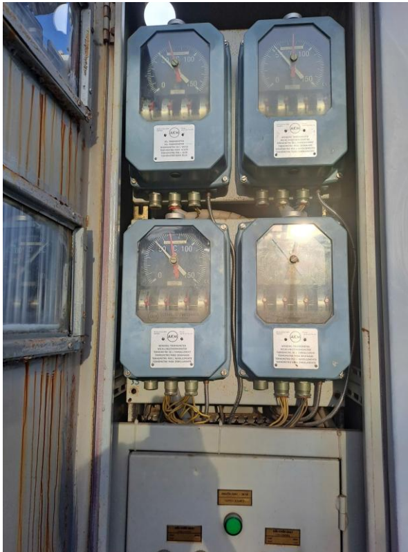
Đồng hồ nhiệt độ dầu, nhiệt độ cuộn dây MBA T2/Mộ Đức
