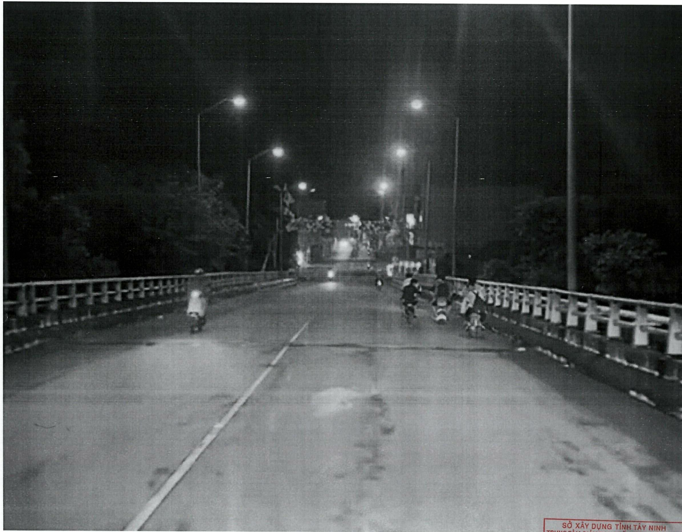
HÌNH HIỆN TRẠNG CẦU HÙNG VƯƠNG
