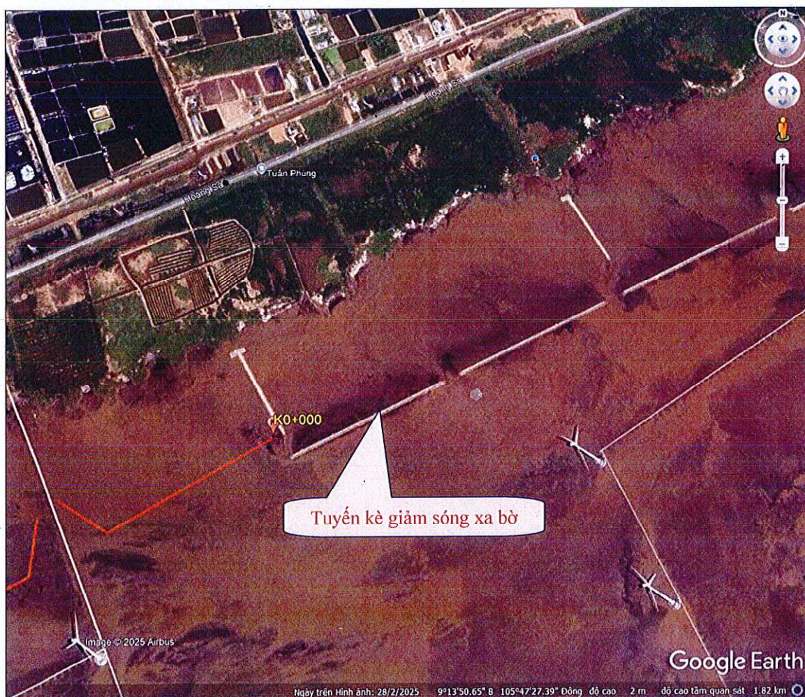
Hình 24: Ảnh chụp tuyến đê (kè) giảm sóng Dự án Gia cố xói lở bờ biển Vĩnh Trạch Đông ở đầu tuyến dự án
