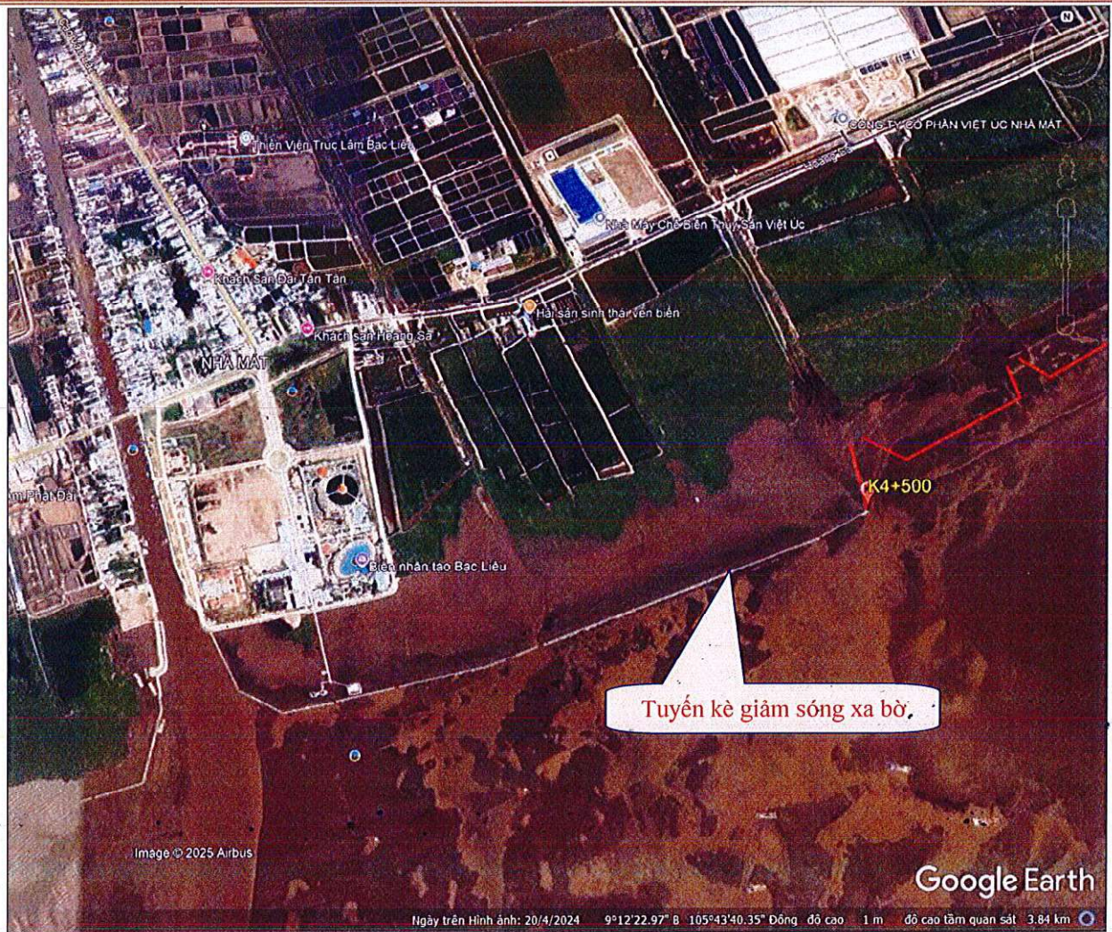
Hình 25: Ảnh chụp tuyến đề (kè) giảm sóng Dự án Đoạn kè cấp bách sát lở bảo vệ đê biển khu vực cửa biển Nhà Mát (bờ phía Đông kênh 30/4) ở cuối tuyến dự án
