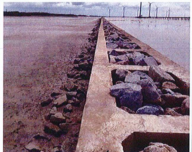
Tuyến kè và gia cố chống xói phía bờ (đá hộc)
