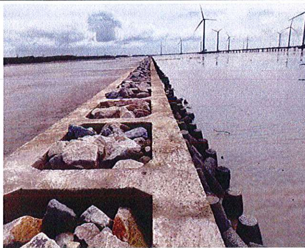
Tuyến kè và gia cố chống xói phía biển (Tetrapod)
