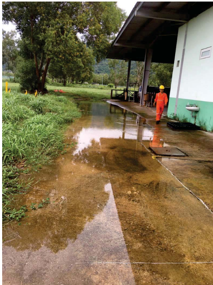
Hình 1 – Ảnh hiện trạng ngập nước tại MCD workshop
