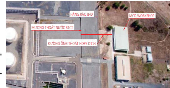
ẢNH MINH HỌA ĐƯỜNG ỐNG THOÁT NƯỚC TẠI MCD WORKSHOP
