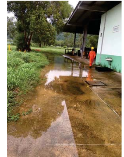
ẢNH HIỆN TRẠNG KHU VỰC ĐÔNG NƯỚC TẠI MCD WORKSHOP
