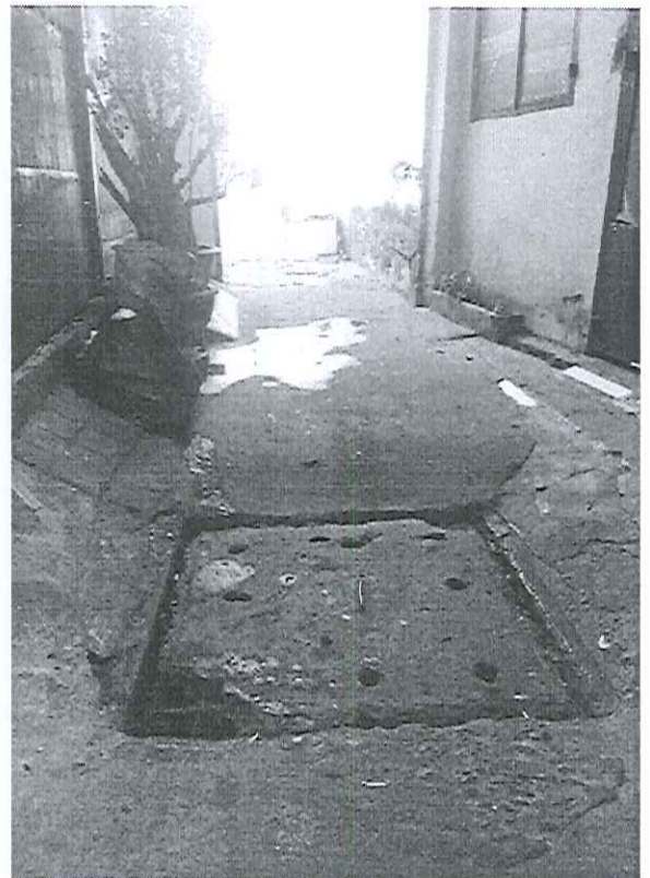
Hệ thống hầm ga hiện hữu
