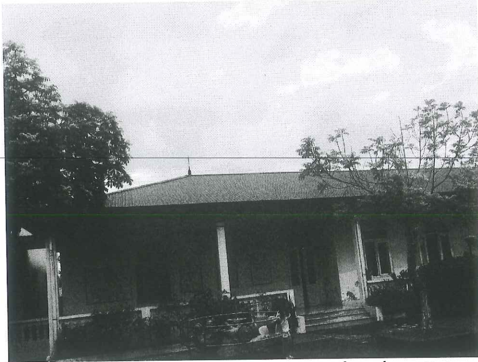
Hình ảnh hiện trạng nhà A3
