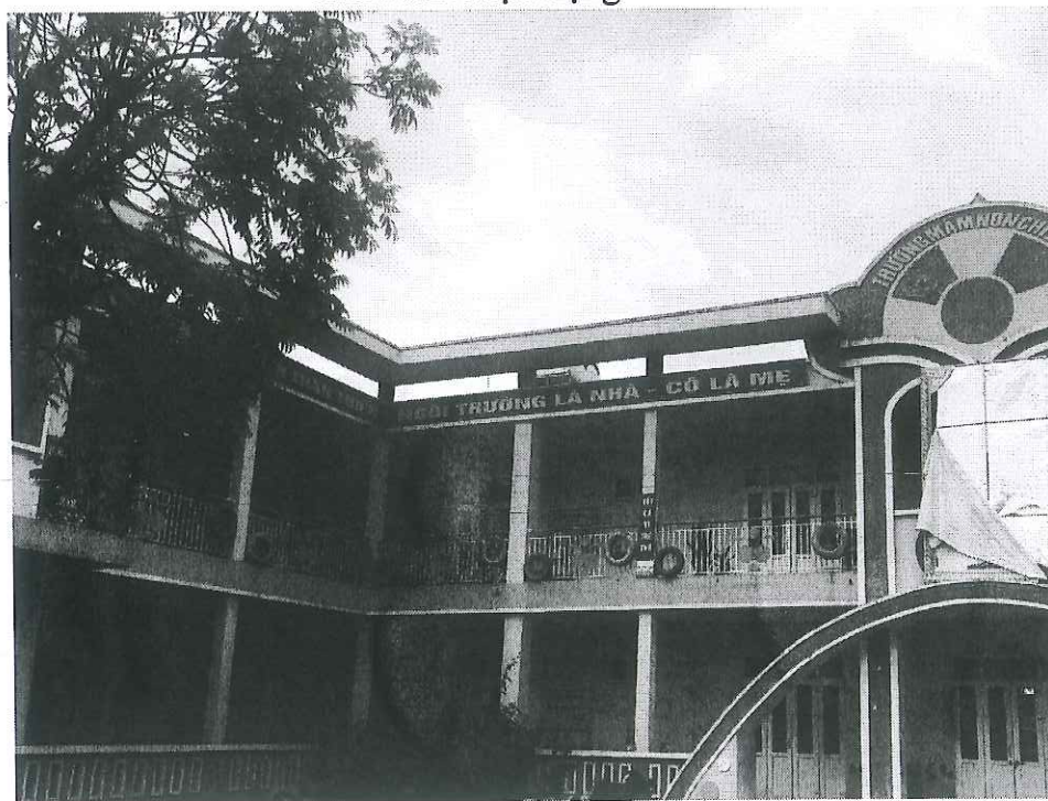
Hình ảnh hiện trạng nhà A1
