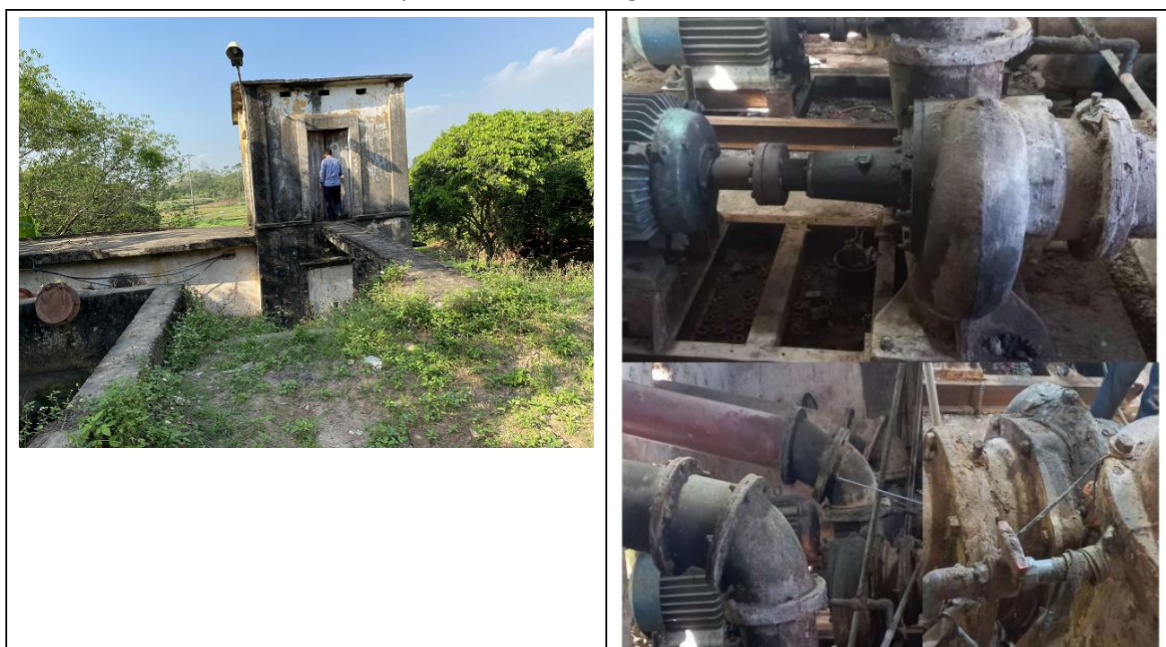
Hình 2.11: ảnh hiện trạng trạm bơm tưới Quán Ngo, xã Tân Phú
