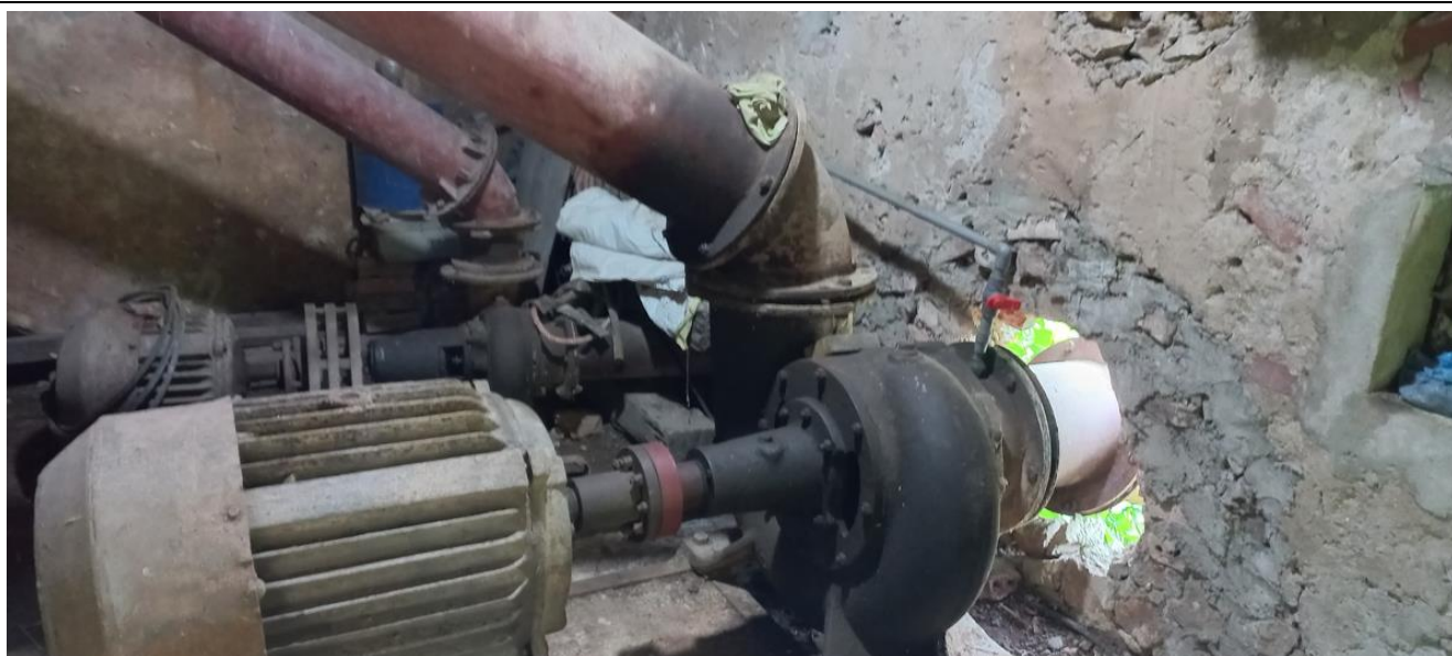
Hình 2.15: Ảnh hiện trạng trạm bơm tưới thứ 2
