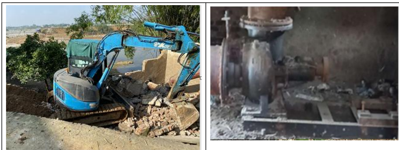
Hình 2.6: ảnh hiện trạng trạm bơm tưới Bến Vôi, xã Cán Hữu
