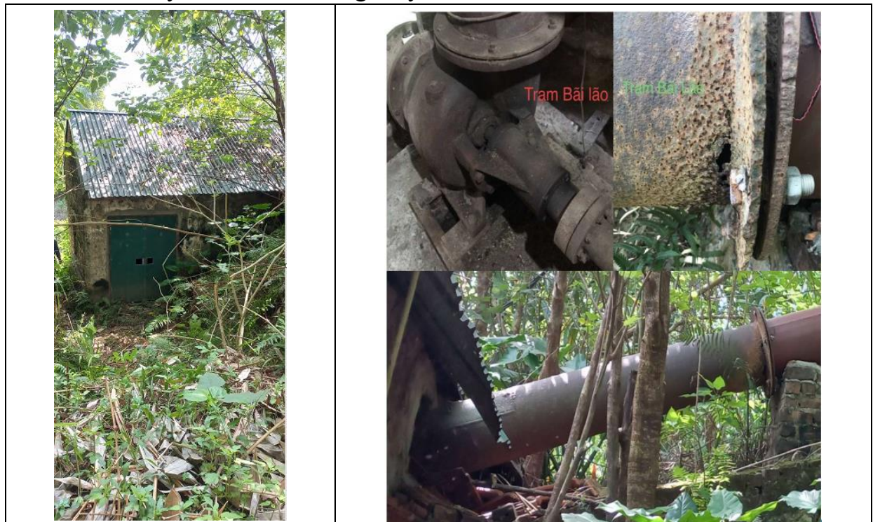
Hình 2.18: ảnh hiện trạng trạm bơm tưới Bãi Lão
