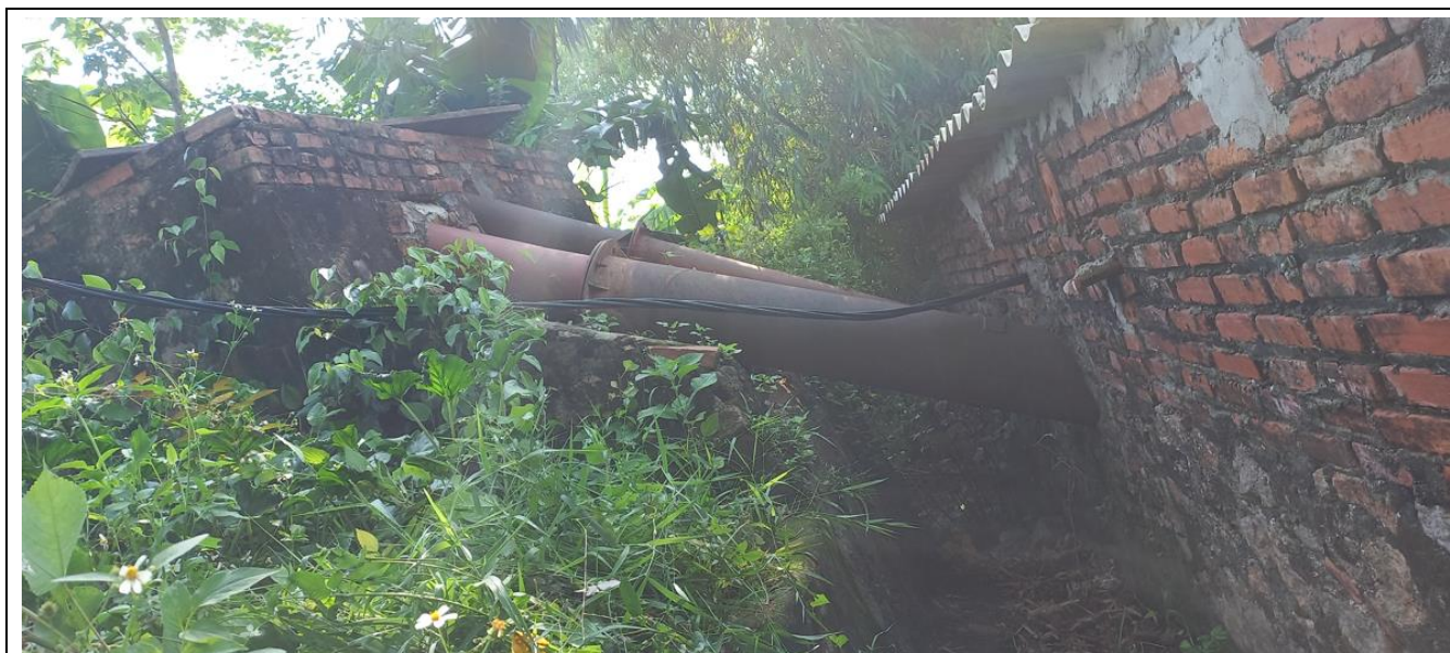
Hình 2.14: Ảnh hiện trạng trạm bơm tưới thứ 2
