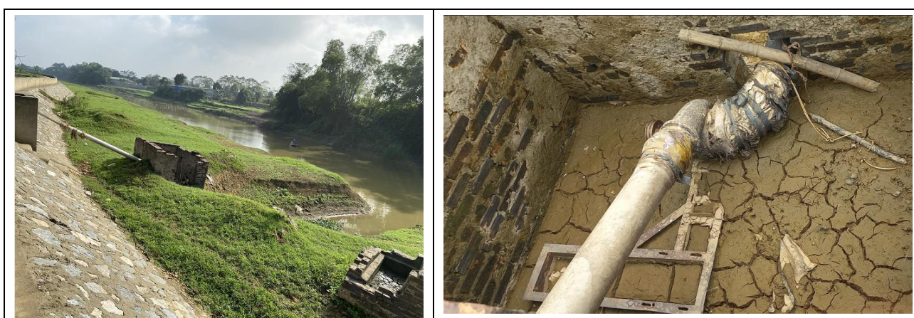
Hình 2.7: ảnh hiện trạng trạm bơm tưới Gò Tuy, xã Cán Hữu
