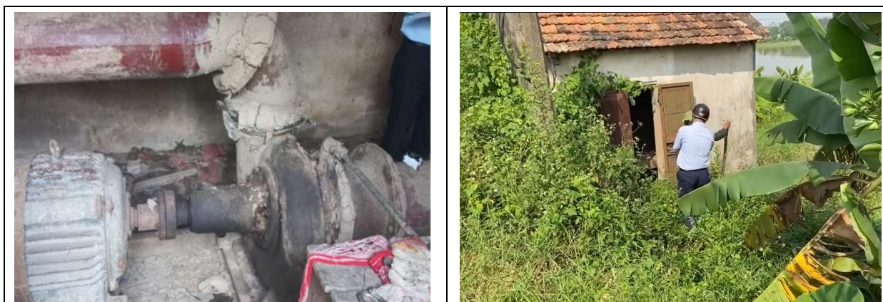
Hình 2.10: ảnh hiện trạng trạm bơm tiêu Chân Đanh, xã Ngọc Liệp
