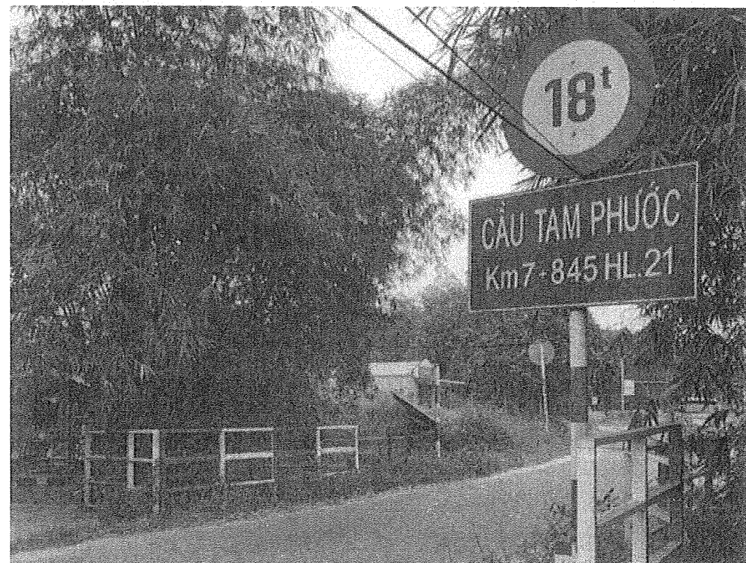
Cầu Tam Phước tại cuối tuyến
