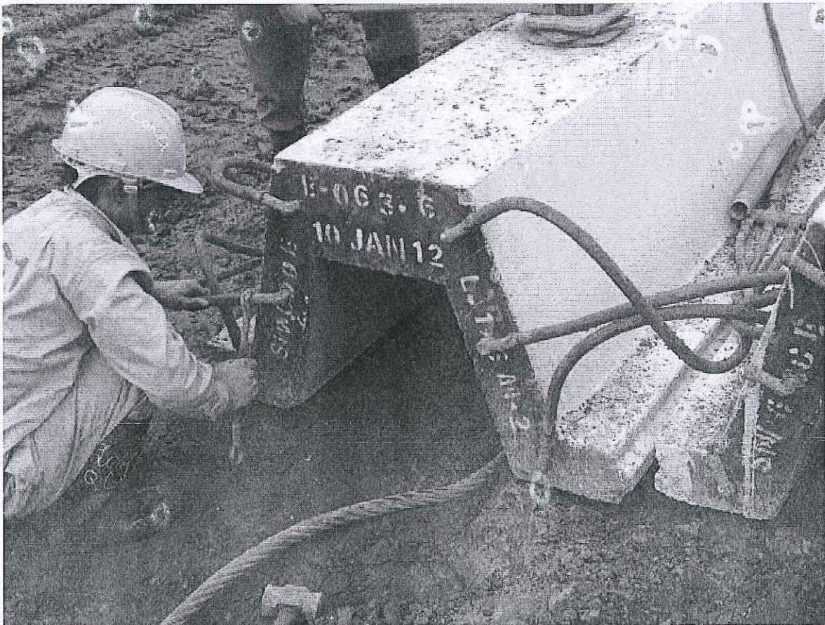
Hình 14: Lắp đặt ống xói nước vào đầu cừ BTCT DƯỠ
