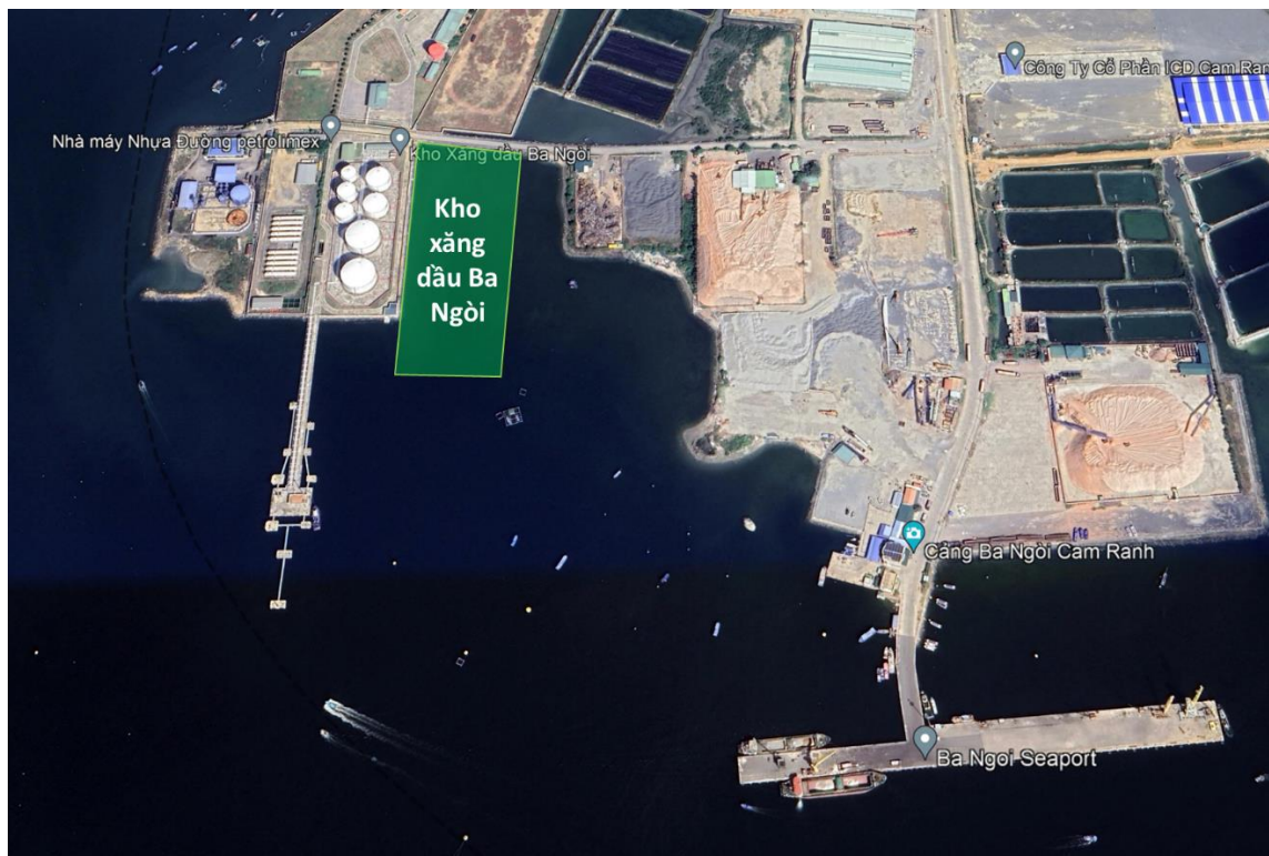
Hình 2.1: Khu vực xây dựng Kho xăng dầu đầu nguồn kết hợp nhiên liệu bay Ba Ngòi
