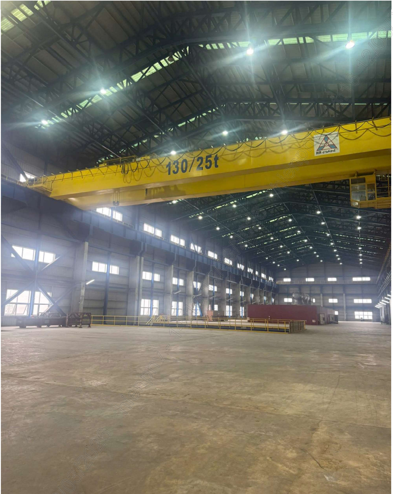
Cầu trục 130 tấn gian tuabine máy phát
