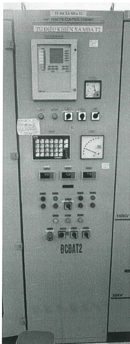
Hình 7. Tủ điều khiển xa ngăn MBA T2
