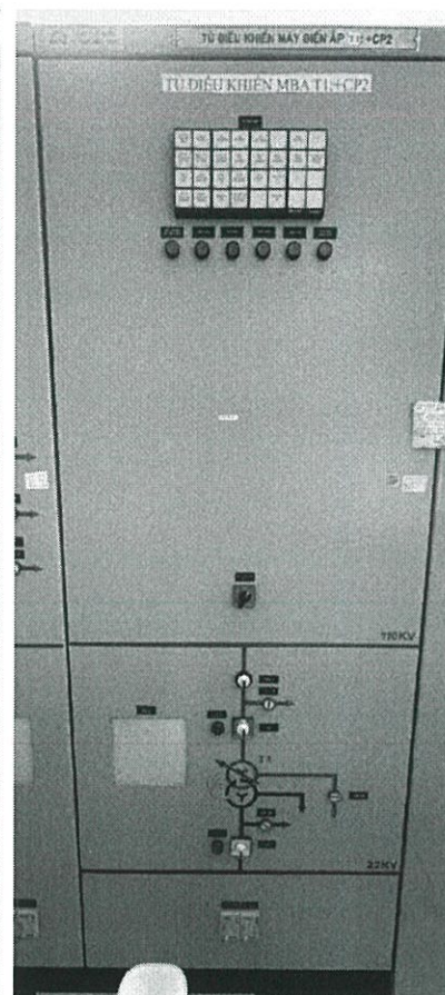
Hình 7. Tủ điều khiển ngăn MBA T1
