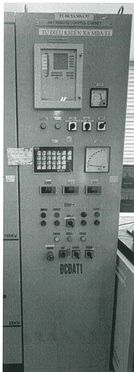
Hình 8. Tủ điều khiển xa ngăn MBA T1
