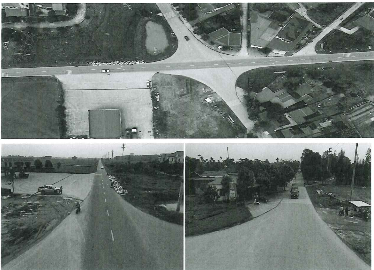
Ảnh hiện trạng tại nút giao
