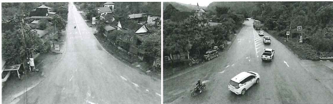
Ảnh hiện trạng tại nút giao
