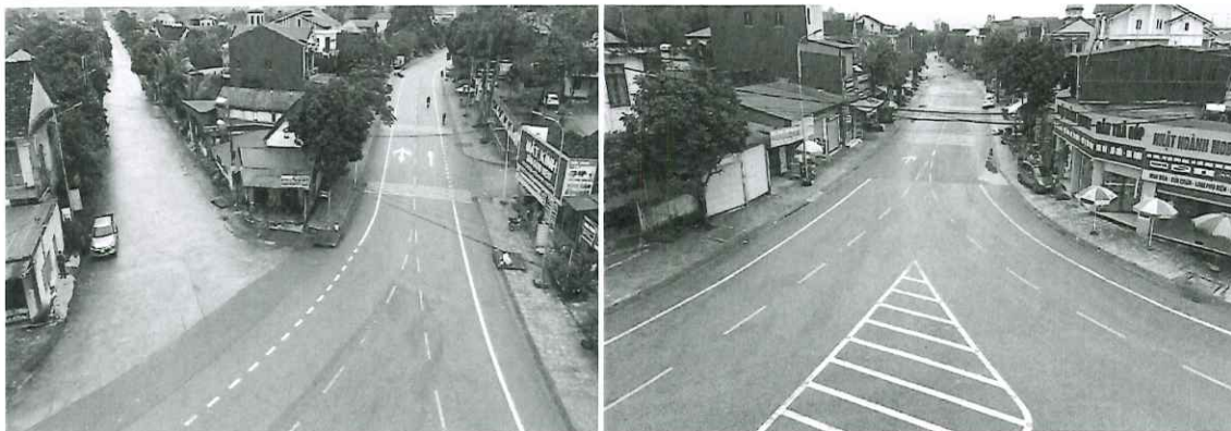
Ảnh hiện trạng tại nút giao
