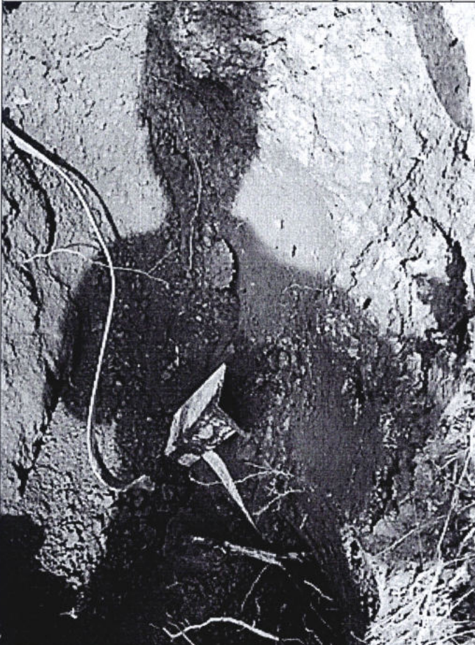
Hình ảnh hệ thống tiếp địa bị bị han gỉ, ăn mòn
