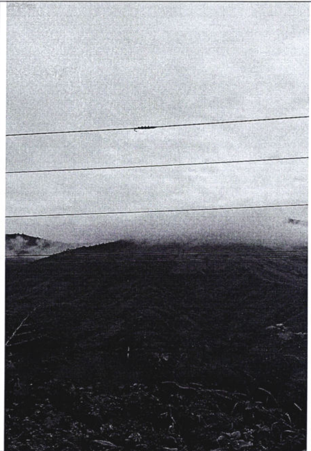
Hình ảnh dây dẫn được nối ở giữa khoảng
