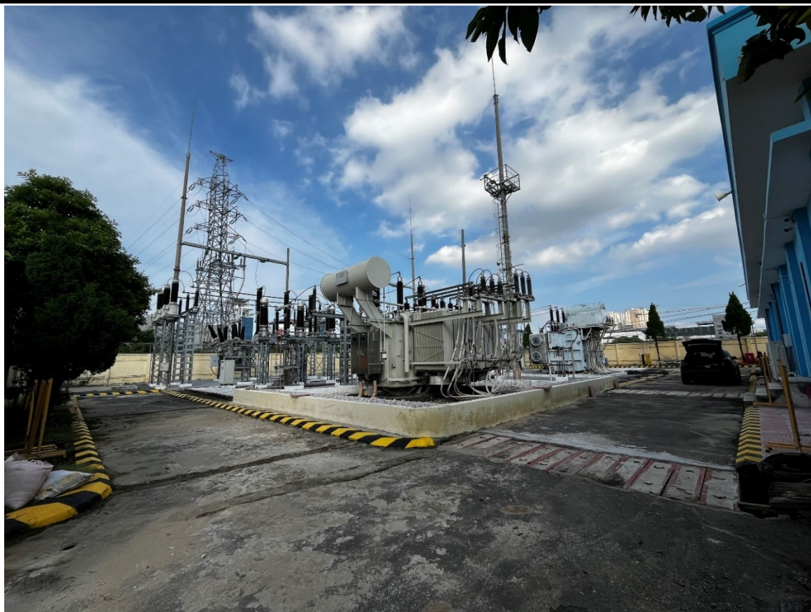
Hình ảnh sân phân phối 110kV ngoài trời
