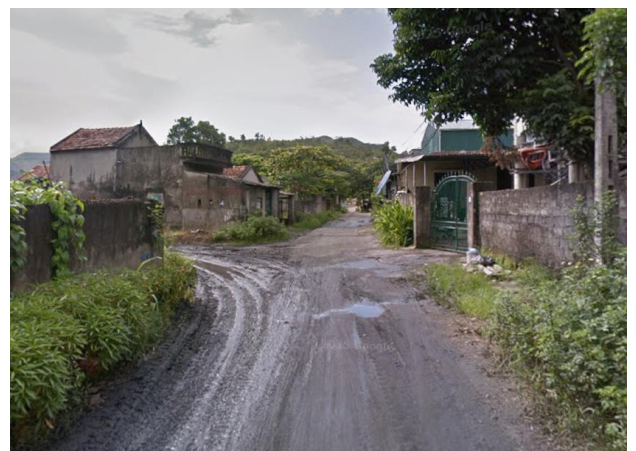
Mặt đường hiện trạng đoạn tuyến 2
