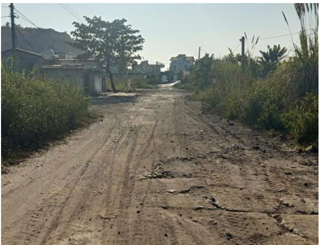
Mặt đường hiện trạng đoạn tuyến 1
