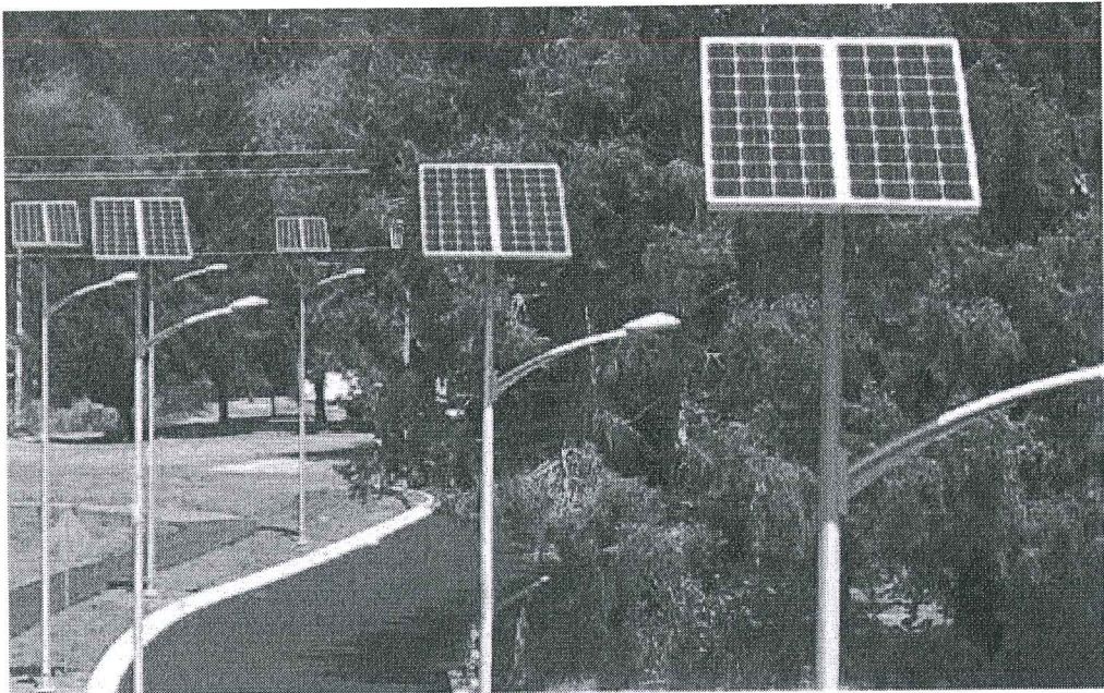
Dự án Xây dựng hệ thống chiếu sáng trên địa bàn xã Vân Đình
