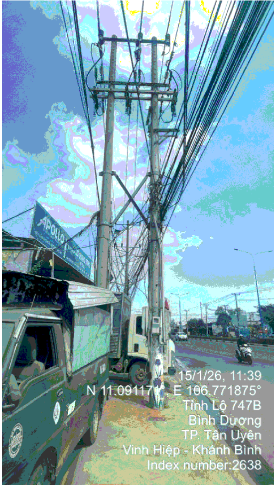
TRỤ 54 TUYẾN 480 TẤN LỘC (Hiện hữu)
