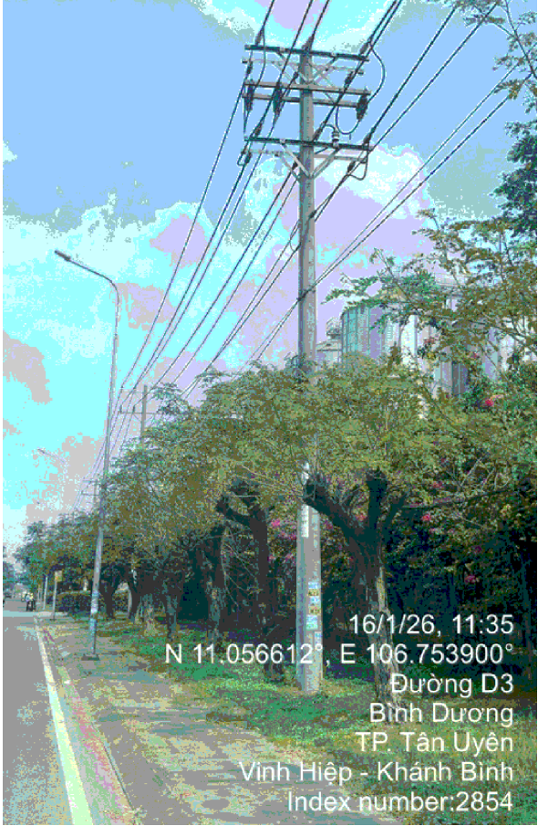
TRỤ 12 TUYẾN 472 HƯNG LỢI (Hiện hữu)
