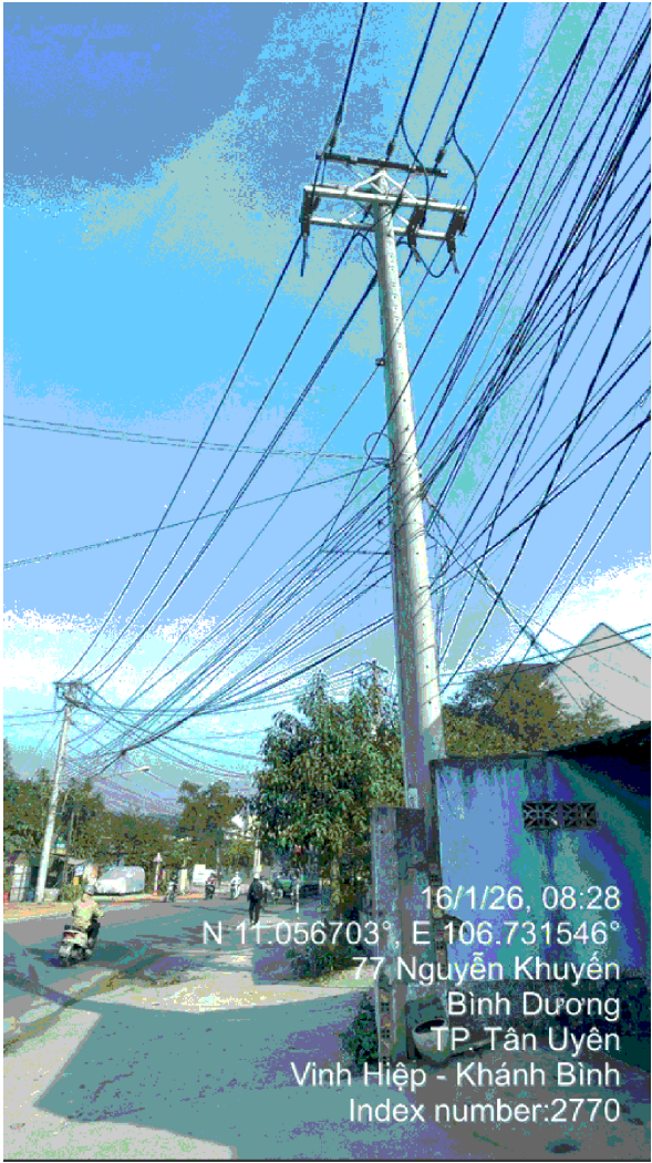
TRỤ 43 TUYẾN 479 ĐA THÀNH (Hiện hữu)
