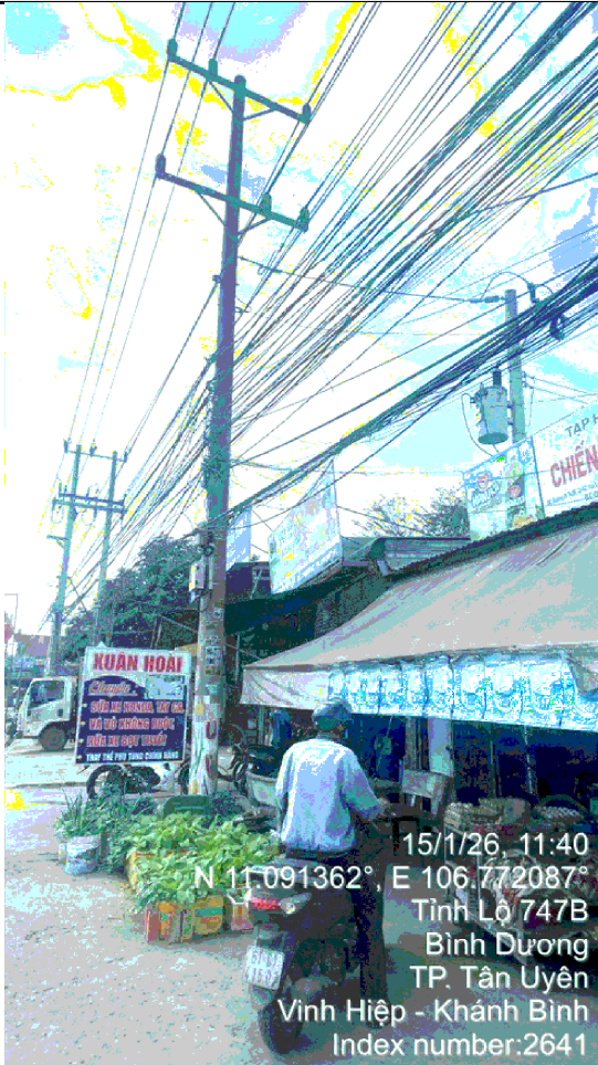
TRỤ 53 TUYẾN 480 TẤN LỘC (Hiện hữu)
