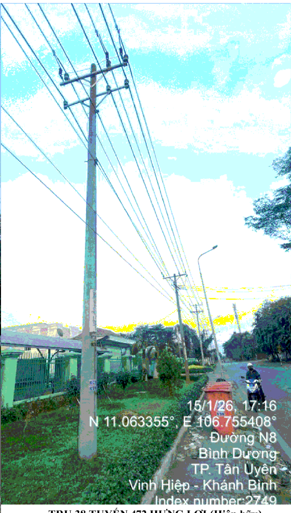
TRỤ 38 TUYẾN 472 HƯNG LỢI (Hiện hữu)
