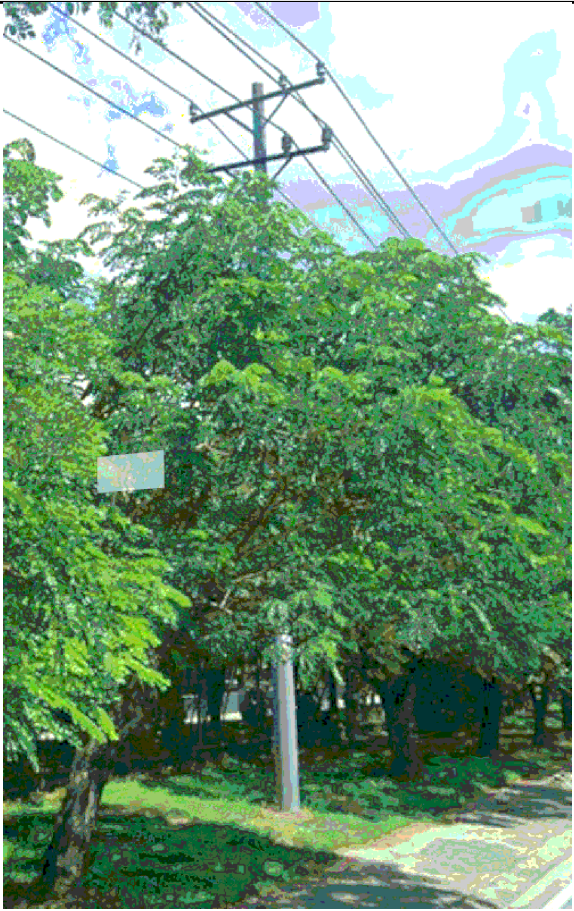
TRỤ 13 TUYẾN 472 HƯNG LỢI (Hiện hữu)
