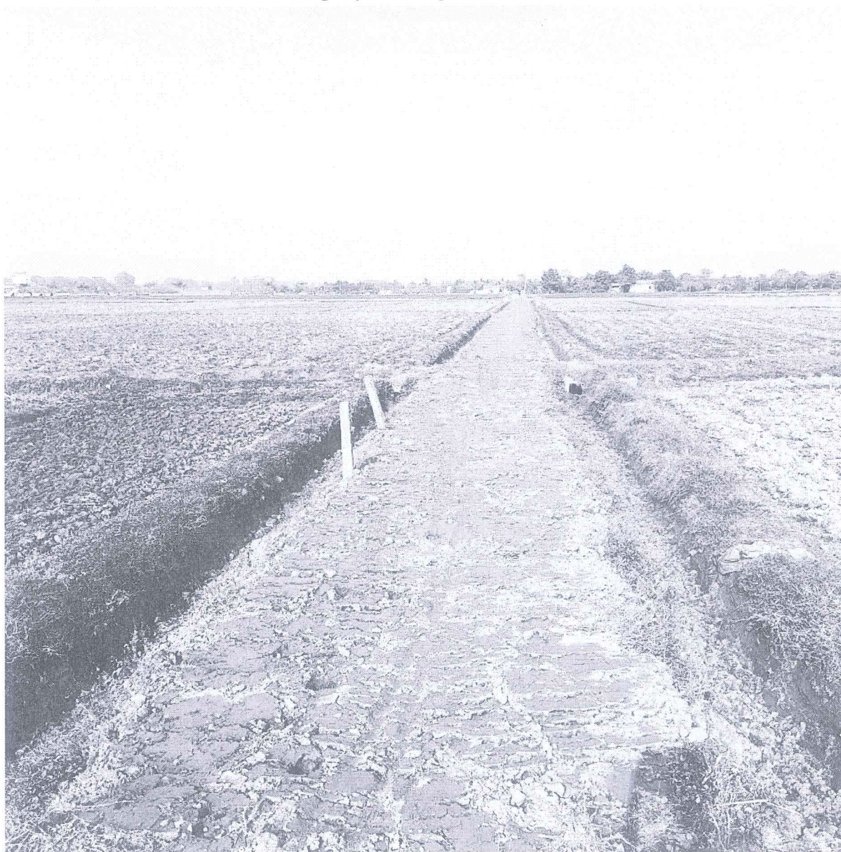
Ảnh 1: Một đoạn đầu tuyến 2 từ đồng Xi Kiếu đến đồng Chảy, hiện trạng đường đất, mương đất hai bên.
