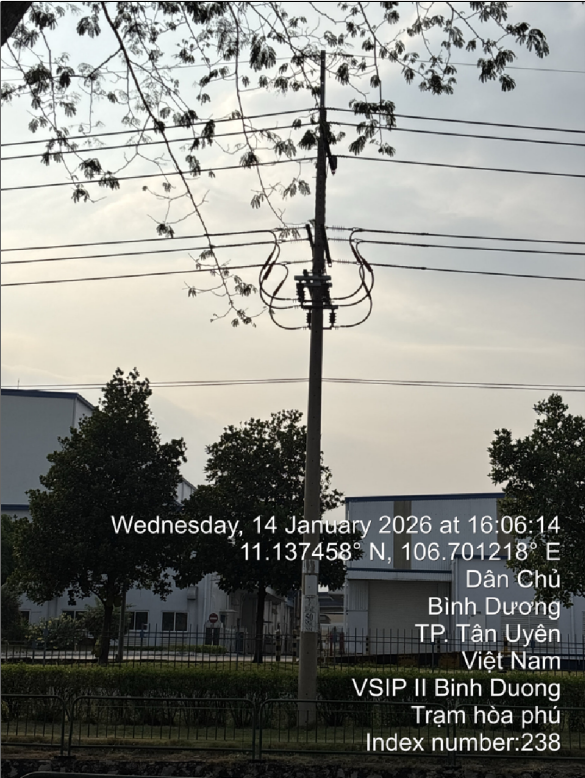
TRỤ 50 TUYẾN 473 NISSIN (hiện hữu)
