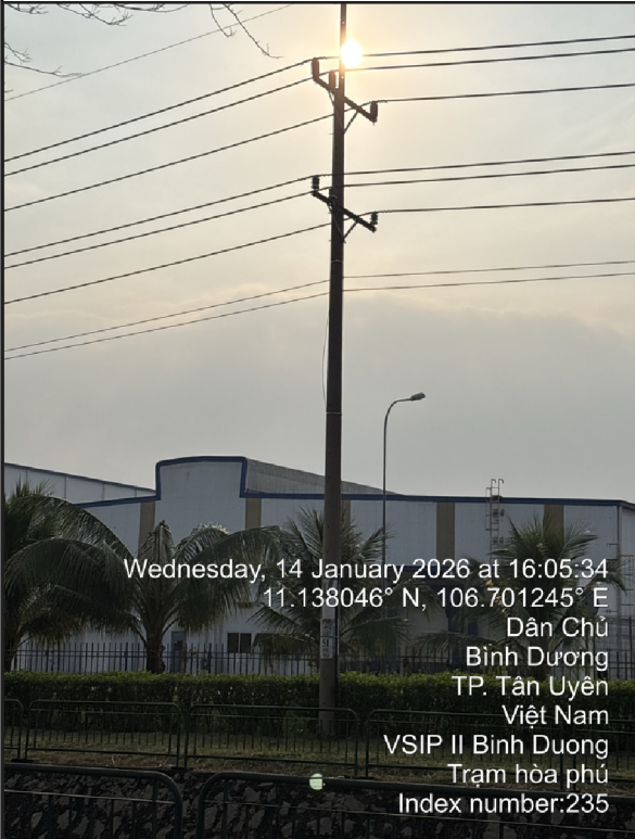
TRỤ 50 TUYẾN 473 NISSIN (hiện hữu)
