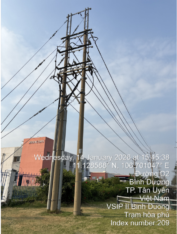
TRỤ 30 TUYẾN 473 NISSIN (hiện hữu)
