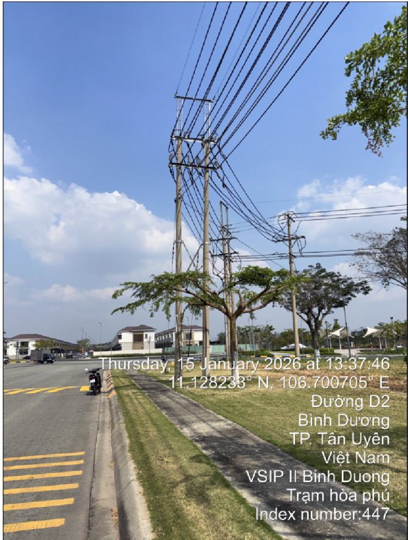
TRỤ 28 TUYẾN 473 NISSIN (hiện hữu)
