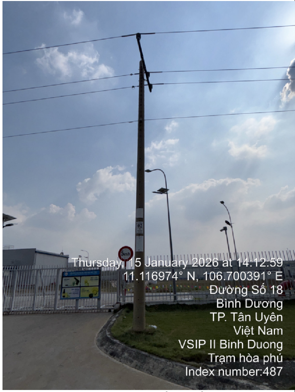
TRỤ 02 NR ĐƯỜNG SỐ 18 -TUYẾN 475 THANH HOA (Hiện hữu)
