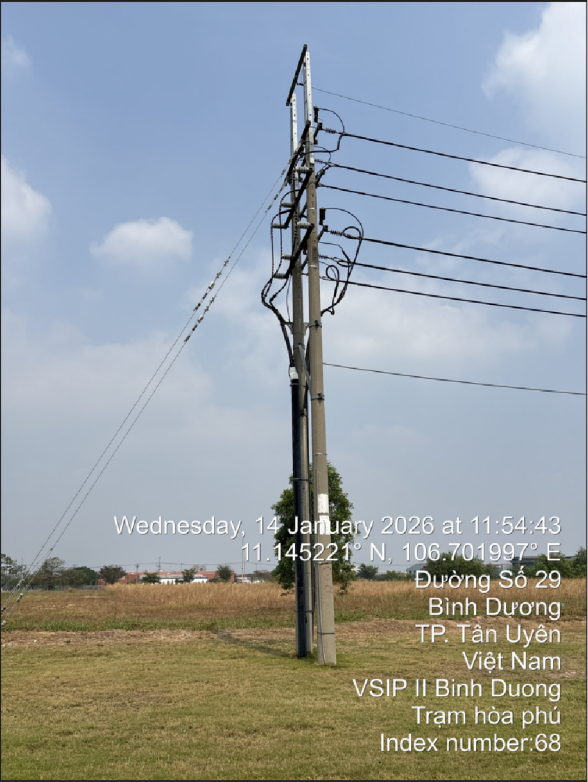
TRỤ 01 NR ĐƯỜNG SỐ 29 NỐI DÀI -TUYẾN 476 NHÀ XƯỞNG (Hiện hữu)
