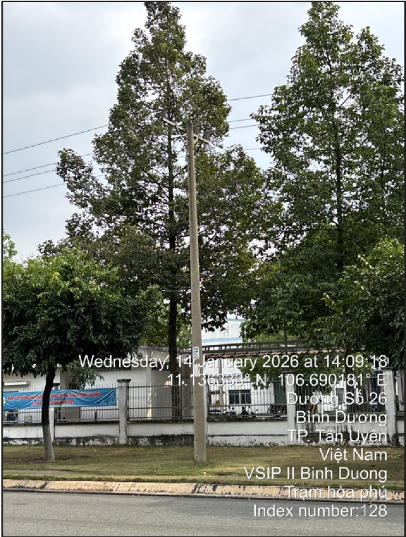
TRỤ 22 NR ĐƯỜNG 26-TUYẾN 471 VĨNH TÂN (hiện hữu)
