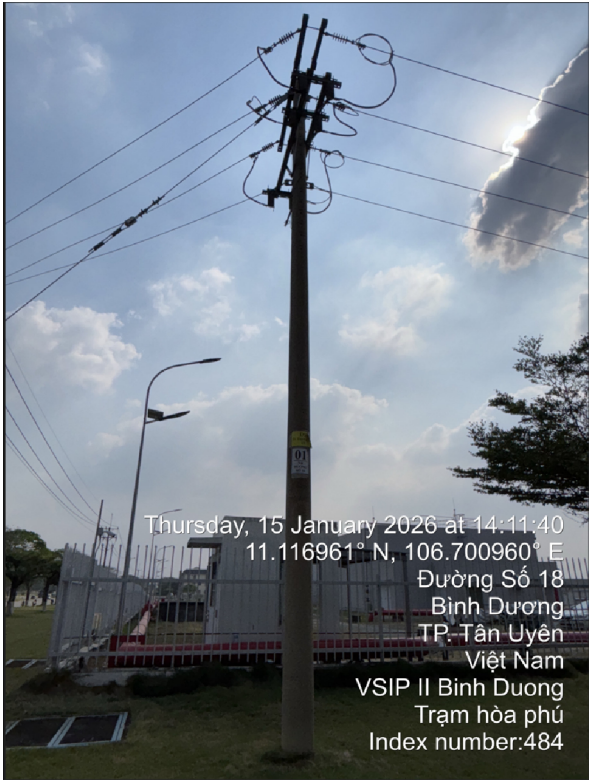
TRỤ 01 NR ĐƯỜNG SỐ 18 -TUYẾN 475 THANH HOA (Hiện hữu)
