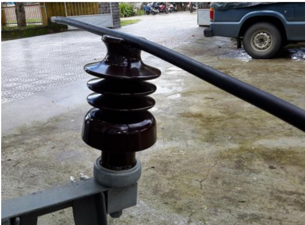
Bước 2. Vòng dây buộc qua cổ sứ về phía trước mặt người thao tác, bắt chéo 01 vòng
