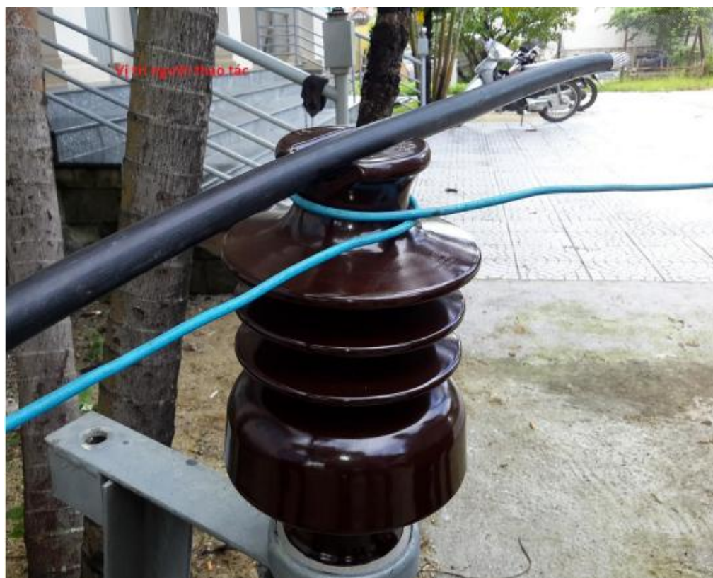
Bước 2. Vòng dây buộc qua cổ sứ về phía trước mặt người thao tác, bắt chéo 01 vòng
