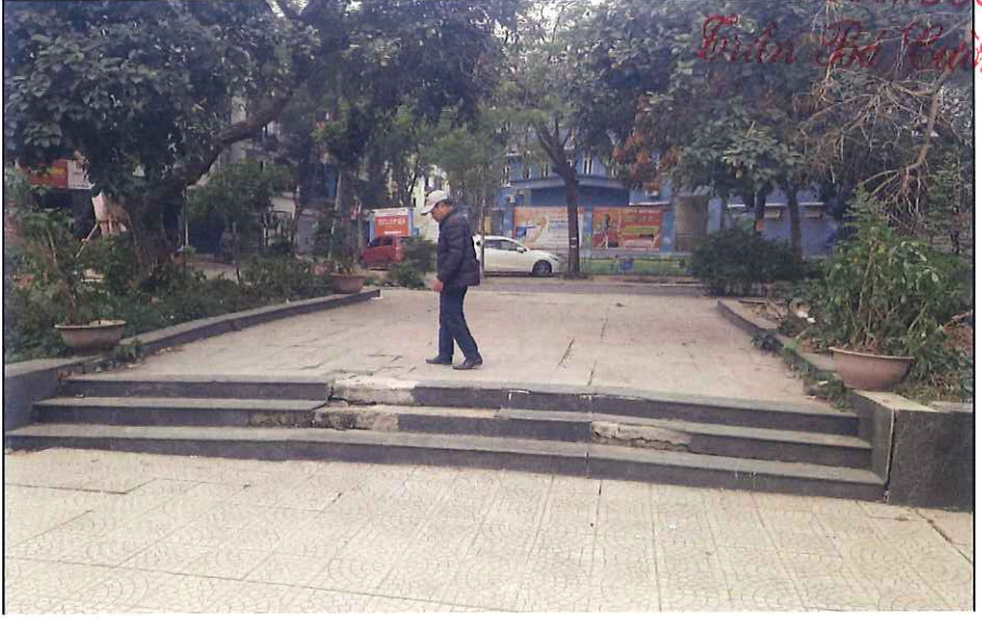
VỊ TRÍ HƯ HỎNG BẬC LÊN XUỐNG, ĐÁ GRANITE VÀ ĐÁ 0.3X0.3M
