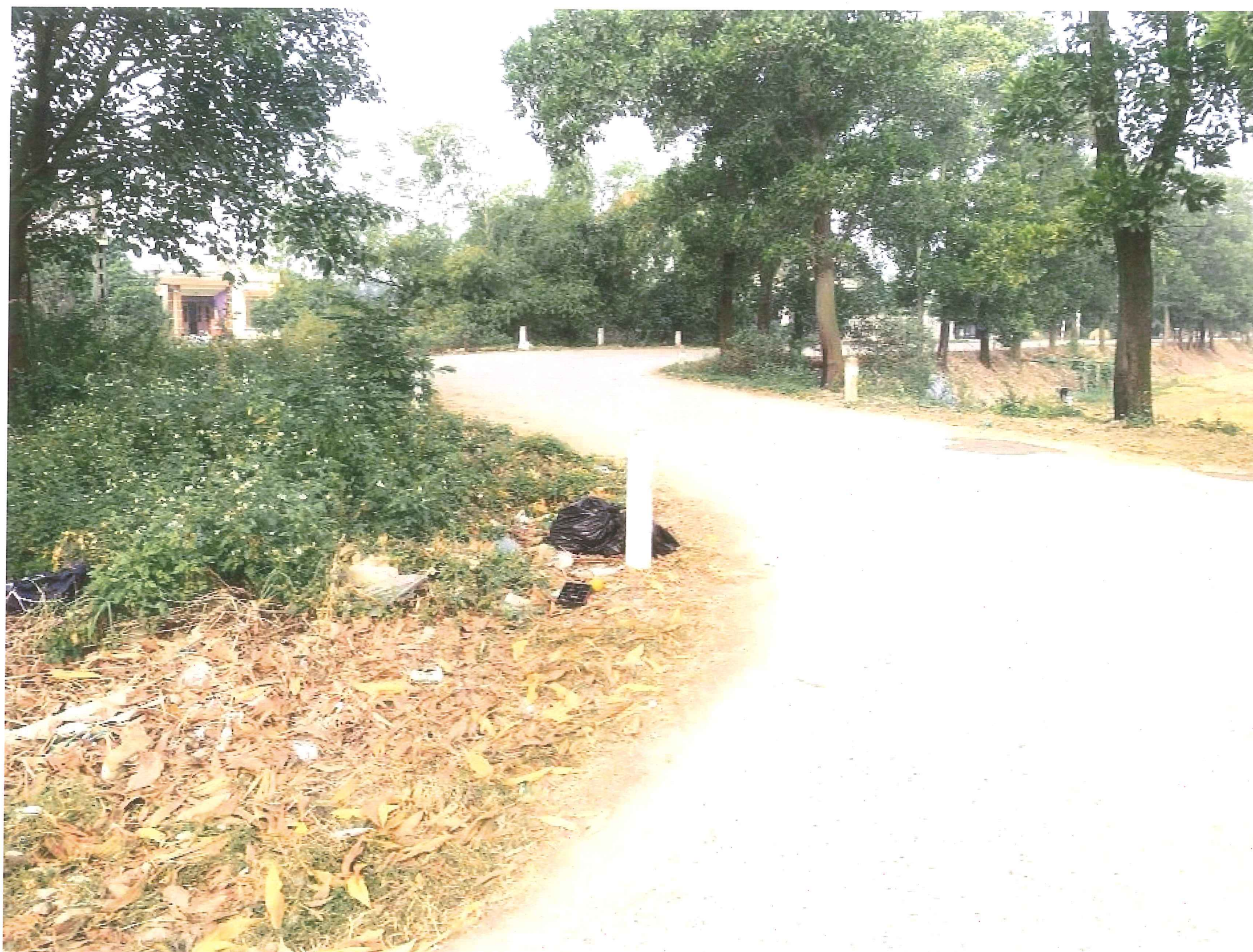
Phần mở rộng sân bãi xe (đoạn ngã 3 đường vào)
