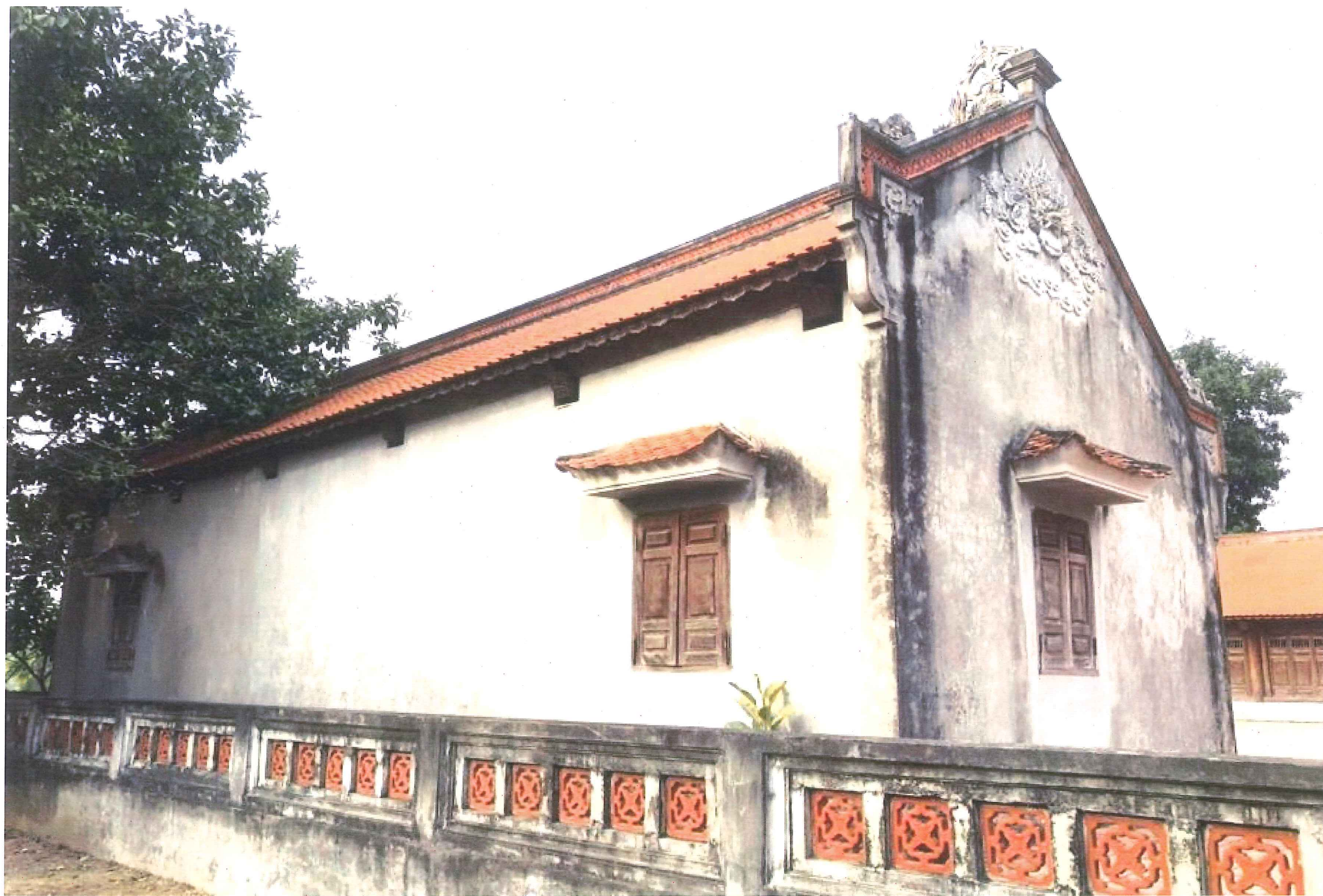
Mặt bên, mặt sau nhà Tả vu
