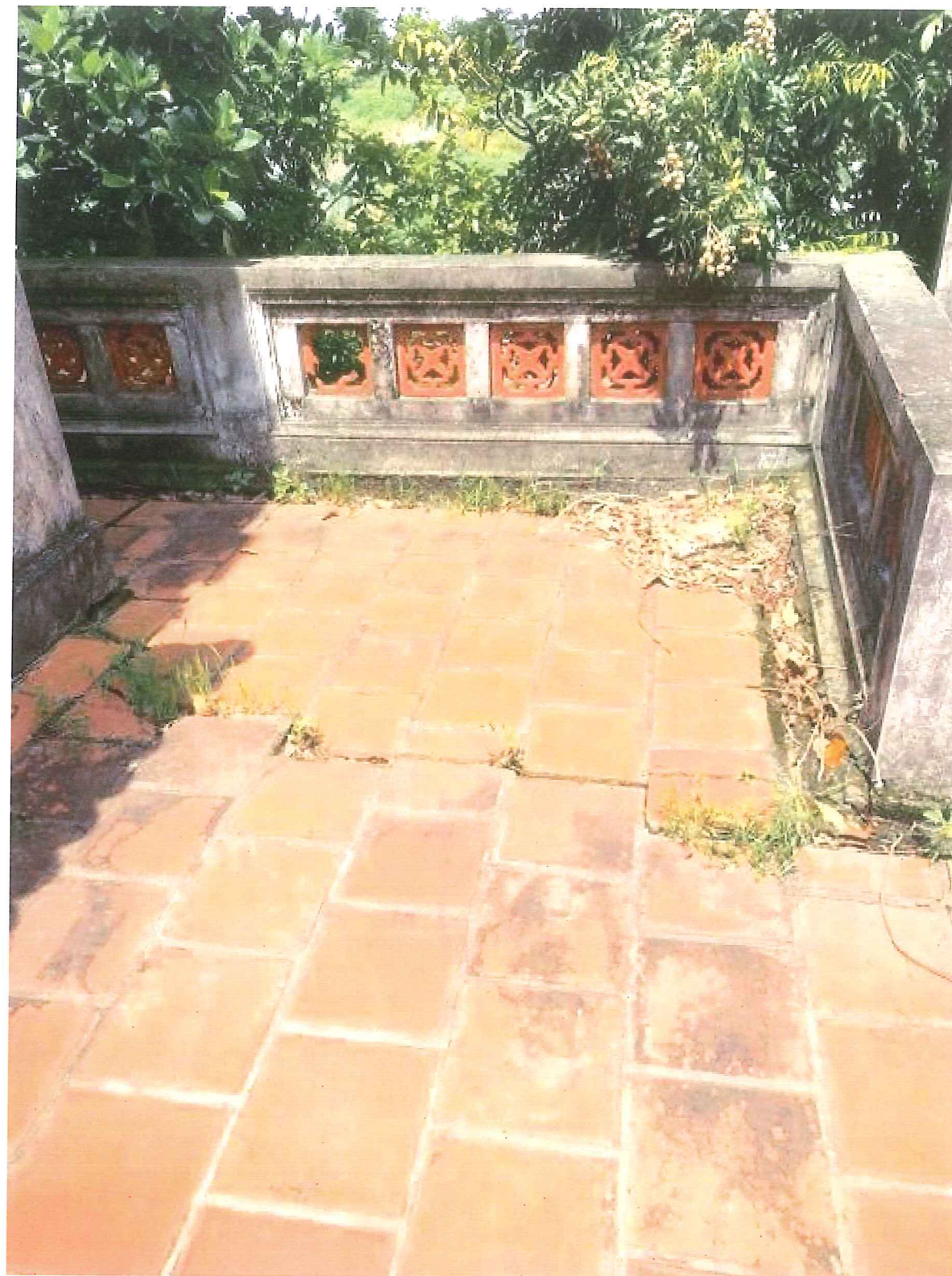
Nền sân, lan can bị nứt vỡ
