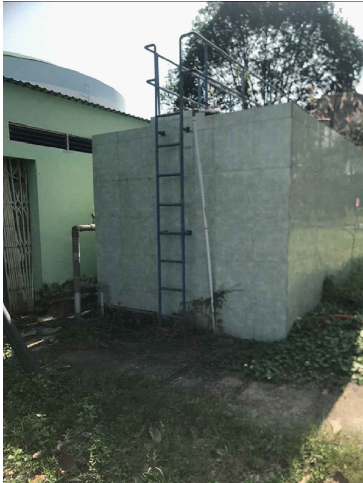
BỂ LỌC NƯỚC RẮNG CỬA
