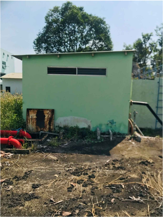
NHÀ BƠM NƯỚC NGẦM
