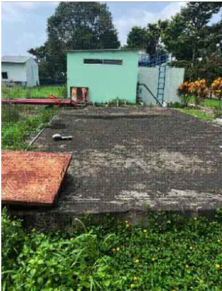
BỂ CHỨA NƯỚC NGẦM
