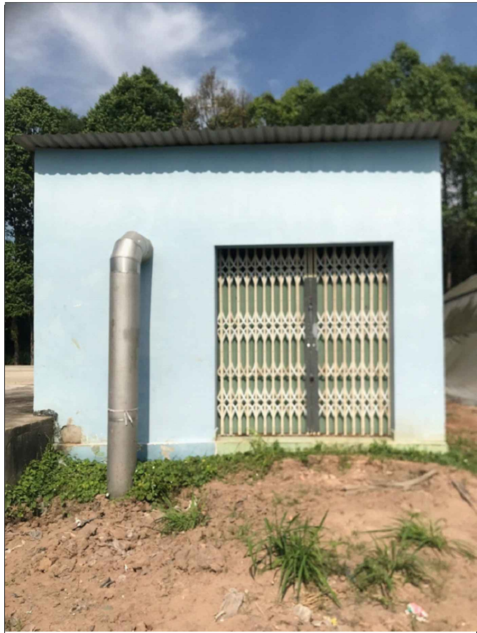
NHÀ BƠM CẤP NƯỚC ĐI
