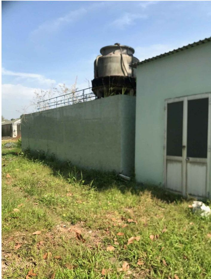
BỂ LỌC NƯỚC RẮNG CỬA
