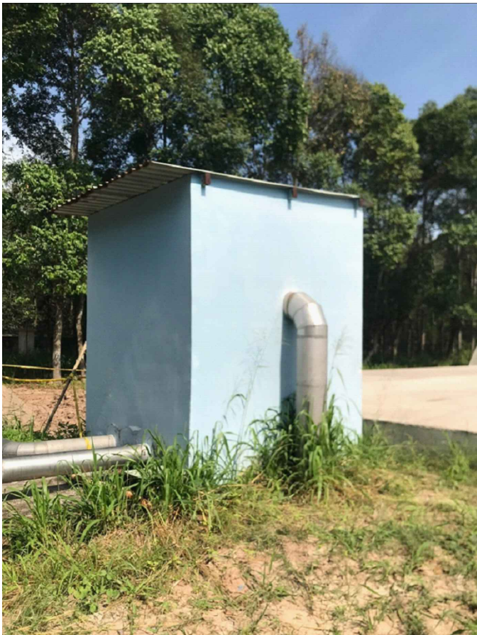
NHÀ CHỨA MÁY BƠM
