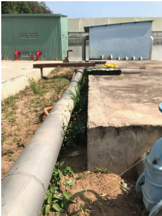
BỂ CHỨA NƯỚC SẠCH
