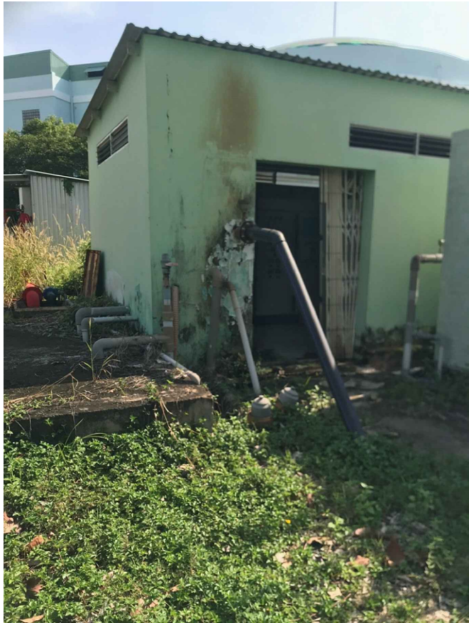
NHÀ BƠM NƯỚC NGẦM
