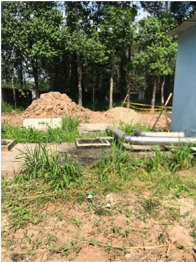
HÓ THU NƯỚC VÀ NGĂN HÚT NƯỚC
