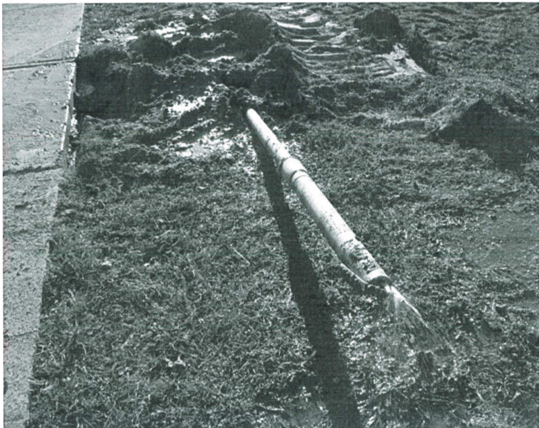
Mũi khoan ló ra khỏi mặt đất
