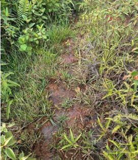
Vùng chân đập hạ lưu có dòng thấm thoát ra gây bất lợi cho mái đập
