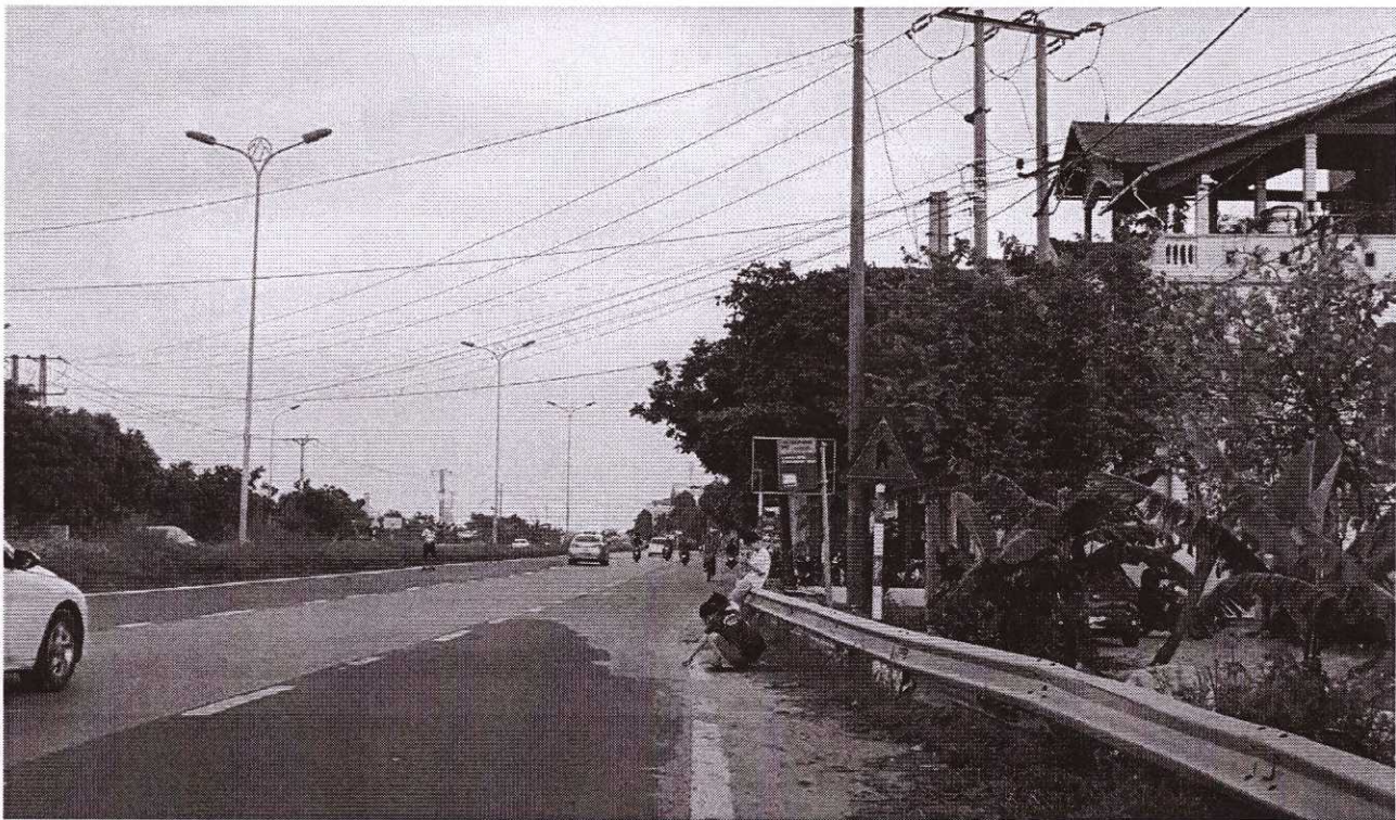
Cột đèn hiện trạng han gỉ, đèn không hoạt động buổi tối.
