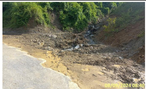
Ảnh 33. Đất đá bồi lấp hố thu cống và mặt đường tại km0+50m_NP1, ngày 12/9/2024
