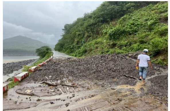
Ảnh 14. Đất đá bồi lấp mặt đường tại km0+450m_NP4, ngày 19/6/2023
