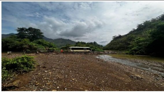
Ảnh 42. Đất đá bồi lấp mặt đường tại km2+135m_NP1, ngày 8/7/2025
