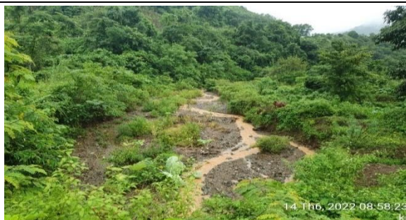
Ảnh 1. Bồi lấp hố thu cống km3+420m_NP1,
