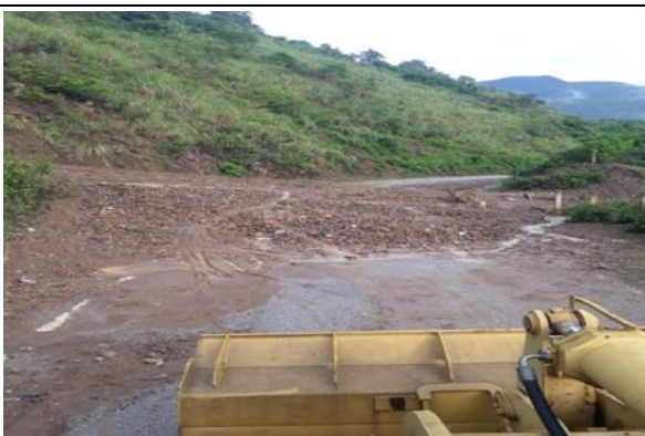
Ảnh 21. Đất đá bồi lấp hố thu, mặt đường tại km0+459m_NP1, ngày 21/8/2023
