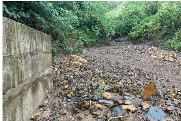
Ảnh 13. Đất đá bồi lấp hố thu trước cống tràn 4.1_NP4, ngày 19/6/2023
