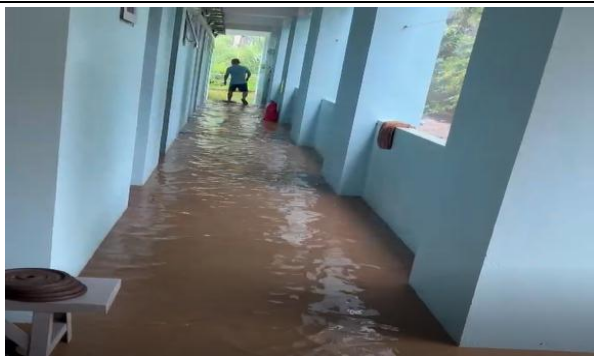
Ảnh 58. Mưa lũ gây ngập úng khu nhà nghỉ chờ ca, nhà F
