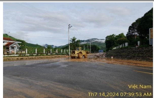
Ảnh 53. Đất đá bồi lấp rãnh thoát nước, mặt đường khu vực km0+00m_NT1
