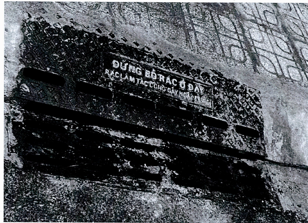
BỐ TRÍ CHUNG BỐ VÍA, LƯỚI CHẮN RÁC BẰNG GANG VỊ TRÍ MIỆNG THU
