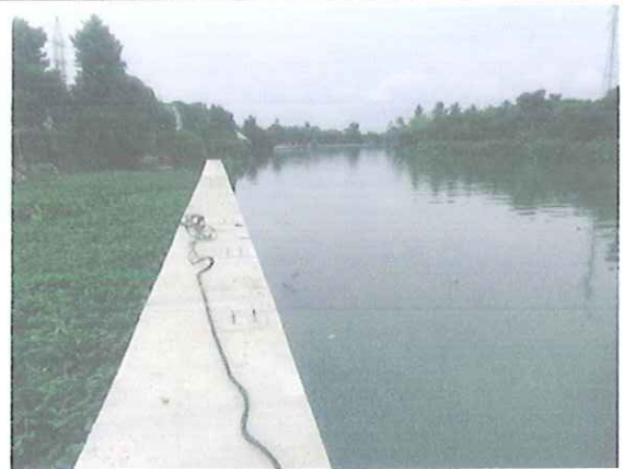
Kè bờ sông Cái phía phường Thống Nhất
