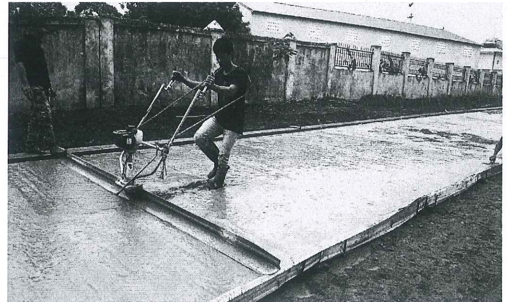
Đầm ngựa tạo mui luyện trong thi công mặt đường bê tông
