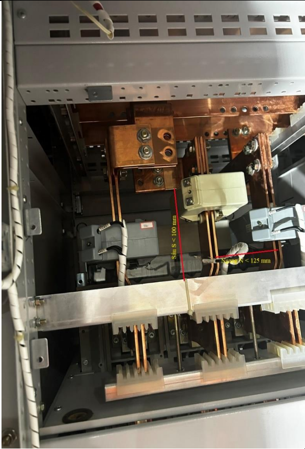
Bố trí lắp đặt của các máy biến dòng điện trong tủ điện phải luôn xuyên qua thanh cái
