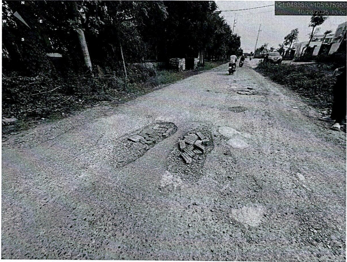
Đoạn Km0-00 đến Km0+150
