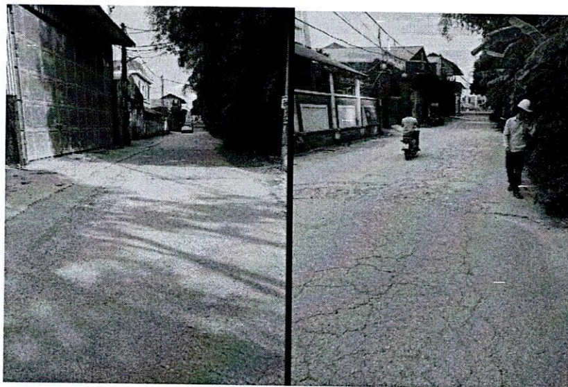
Hiện trạng tuyến đường từ Km1+600 đến cuối tuyến Km1+722,93
