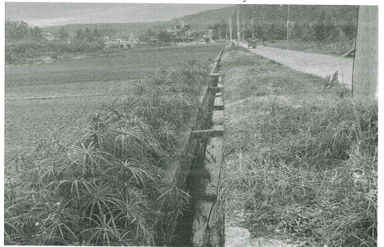
Hình 2: Mương thủy lợi hiện trạng 2 bên tuyến
