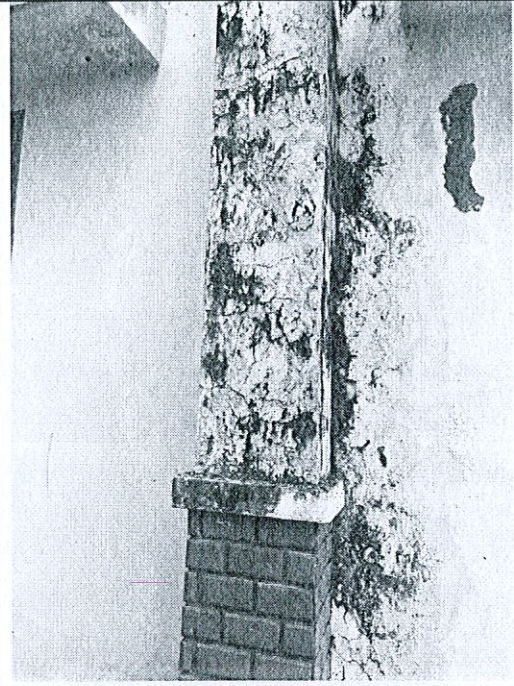
Tường ngoài: Tường sơn nước nhiều vị trí nứt nẻ, rêu mốc, bong tróc
