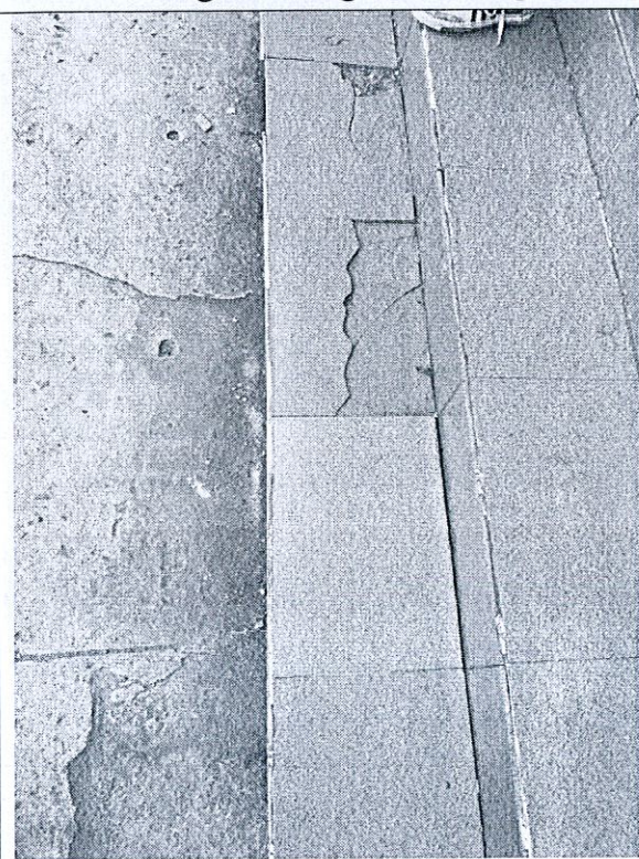
Bậc tam cấp: bậc tam cấp lát gạch sụt lún, nhiều vị trí hư hỏng, nứt bề
