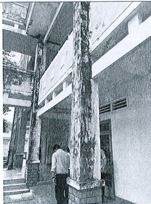
Tường trong, tường ngoài: Tường sơn nước nhiều vị trí nứt nẻ, rêu mốc, bong tróc.
