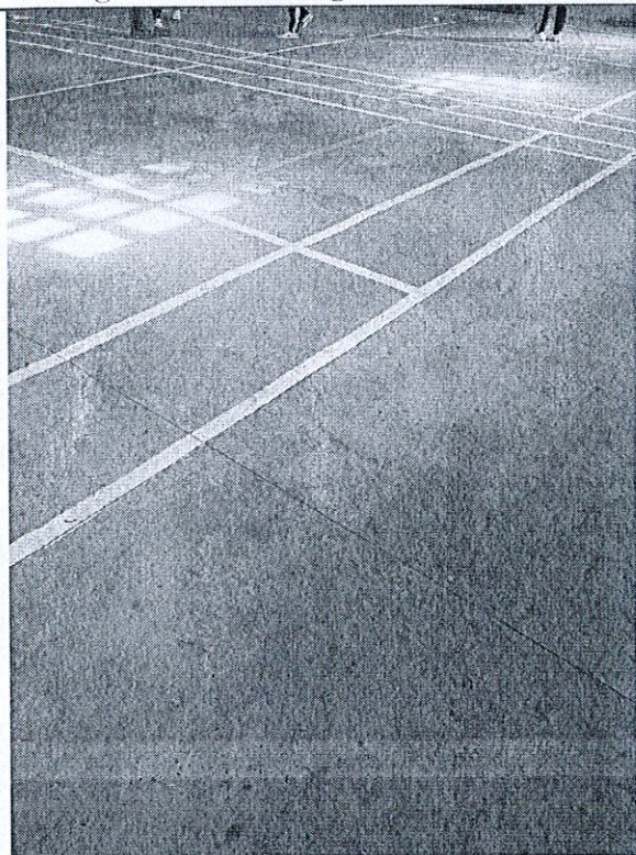
Nền bê tông xi măng hiện trạng còn tốt.
