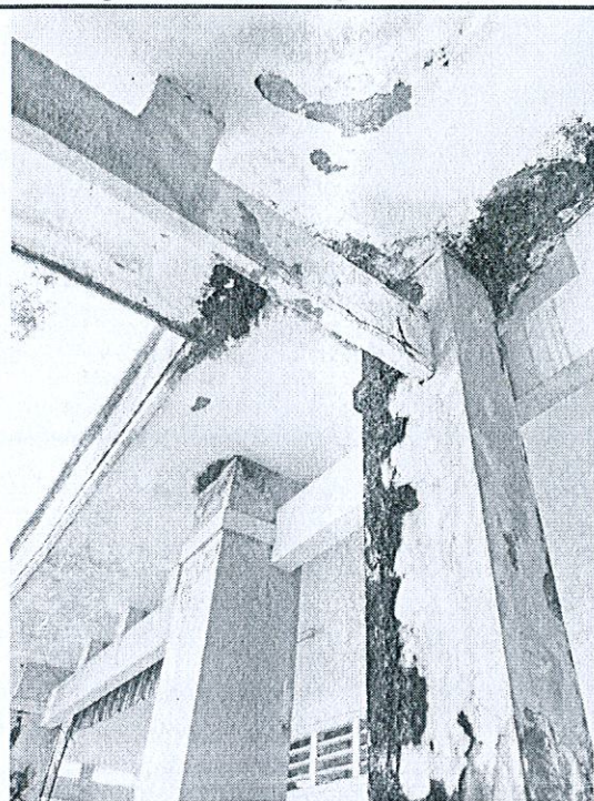
Trần bê tông cốt thép (BTCT): Trần thấm nước mưa, bong tróc, hoen ố
