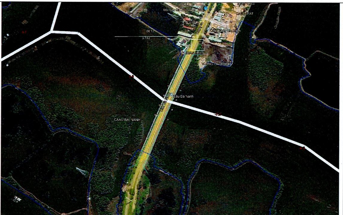
Hình 14: Cầu Bà Nanh qua Sông Rạng có bề rộng sông 220m chiều dài cầu 380m
