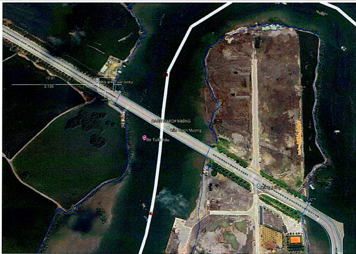
Hình 7: Cầu Rạch Mương qua Sông Sao có bề rộng sông 220m _chiều dài cầu 320m
